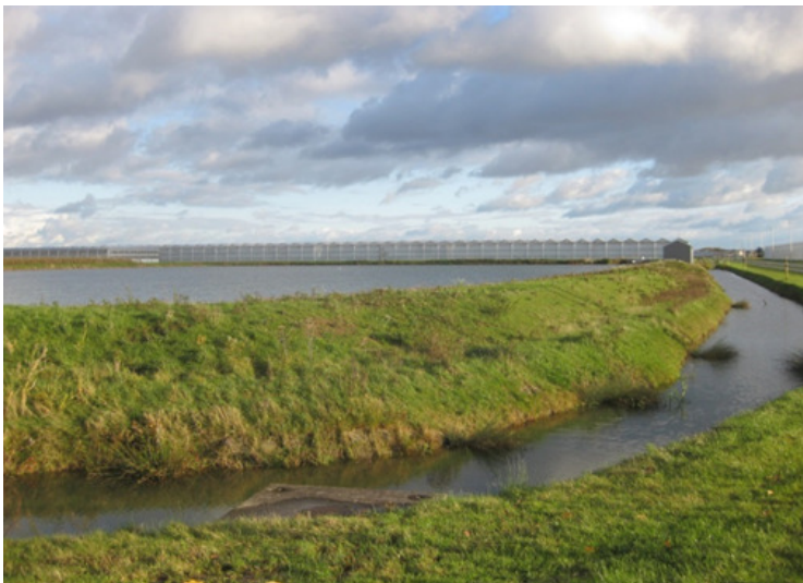
Figuur 7: Het gietwaterbassin in het tuinbouwgebied Bergerden, omringd door een dijk en sloot
