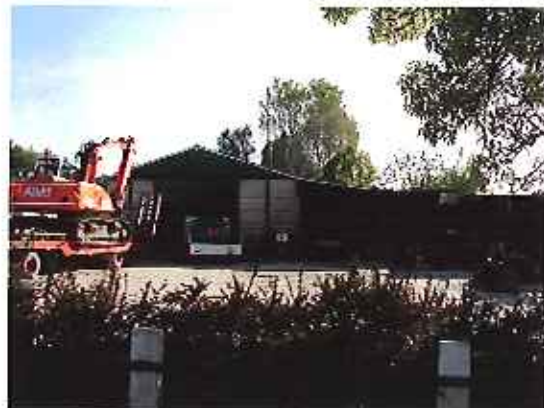
Te saneren bedrijfsbebouwing
