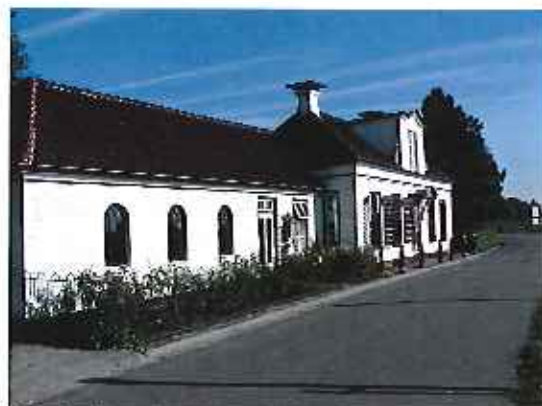
Woonhuis aan de Trekweg
