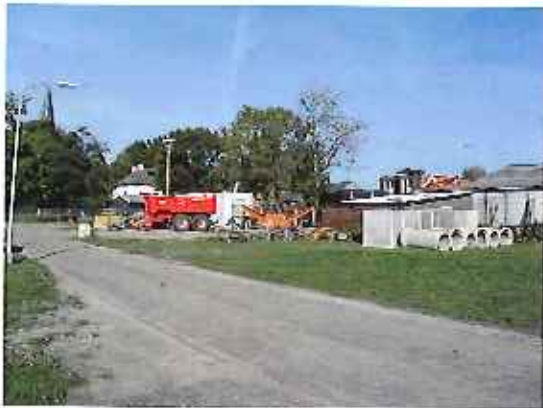
Te saneren bedrijfsbebouwing
