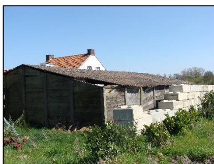
Foto 5. Te slopen schuur
