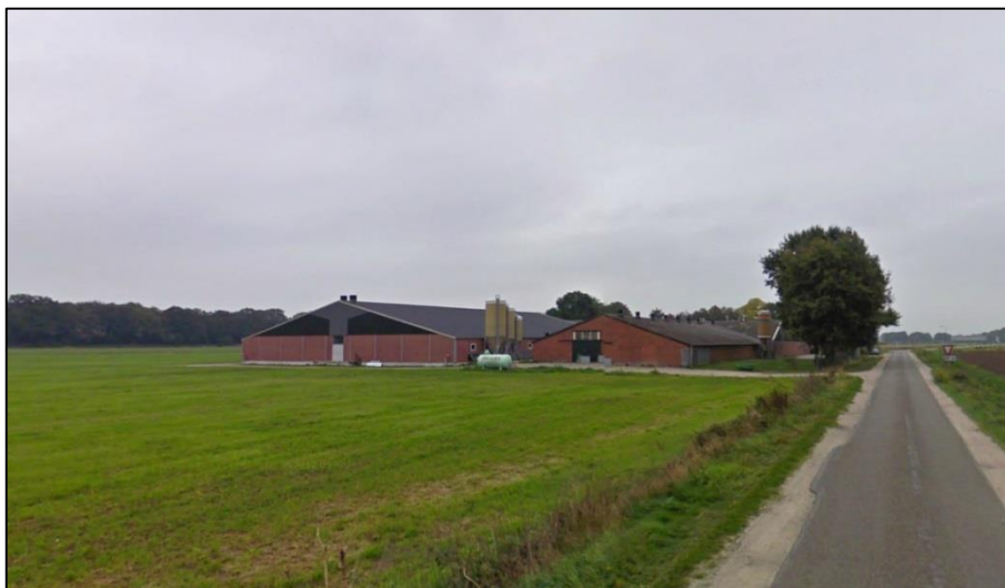
Aanzicht achterzijde vanaf Boerderijweg
