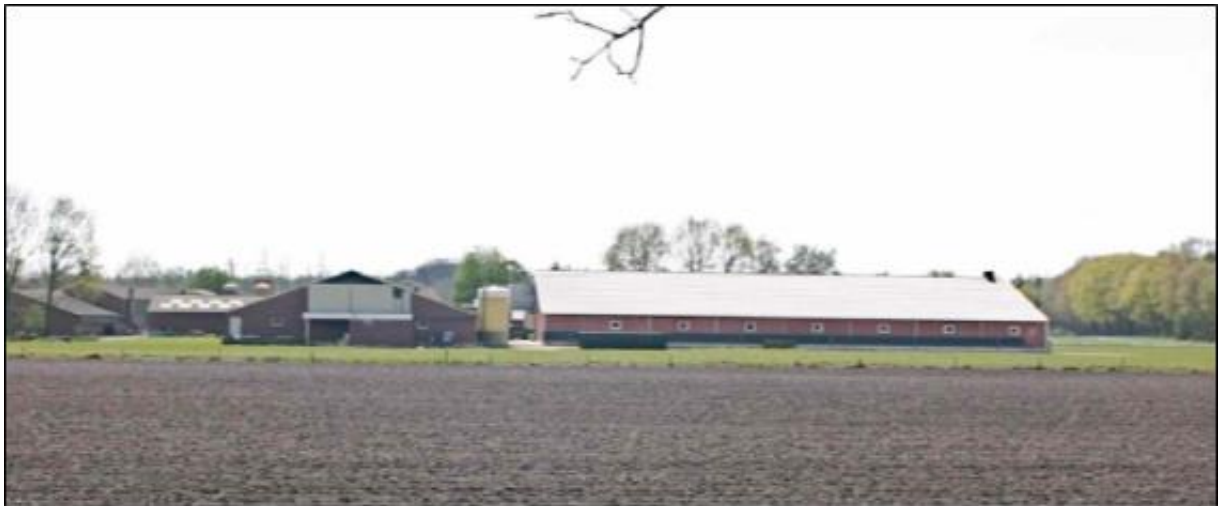
Aanzicht bedrijf vanaf noordzijde
