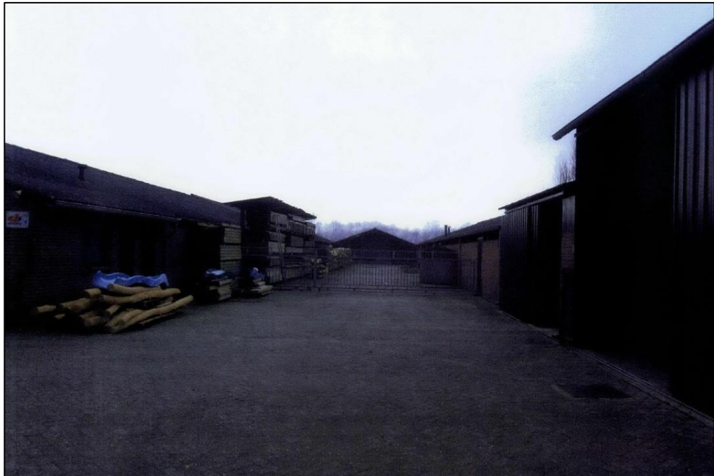
De houtopslag (aan de linker achterzijde). Bron: StAB-advies 39671, 30 april 2015.
