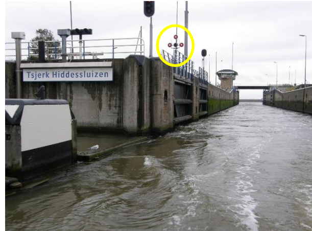
Links de ingang naar de jachthaven van de HWS en de Noordergracht. Op de foto rechts staat de sluis open tijdens het spuien. Verkeersteken H3a uit het BPR dat aangeeft dat er gespuid wordt, is omcirkeld.
