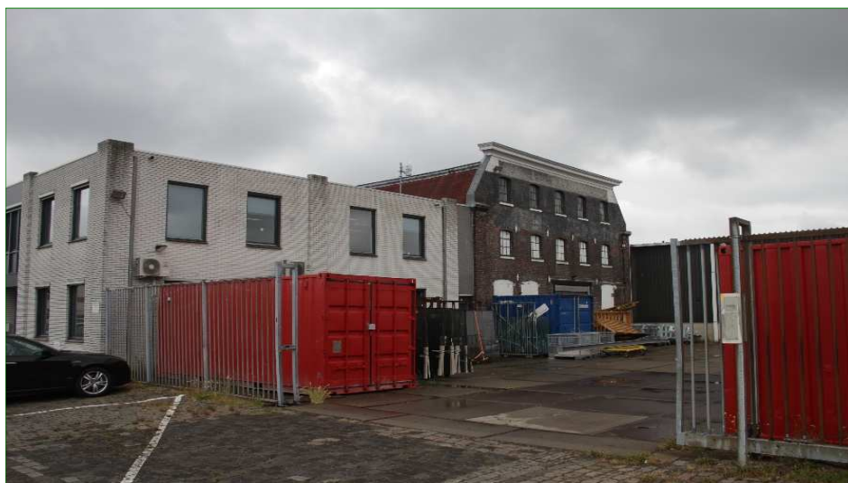
Van links naar rechts: het kantoorpand, monumentale gebouw, en de loods.
