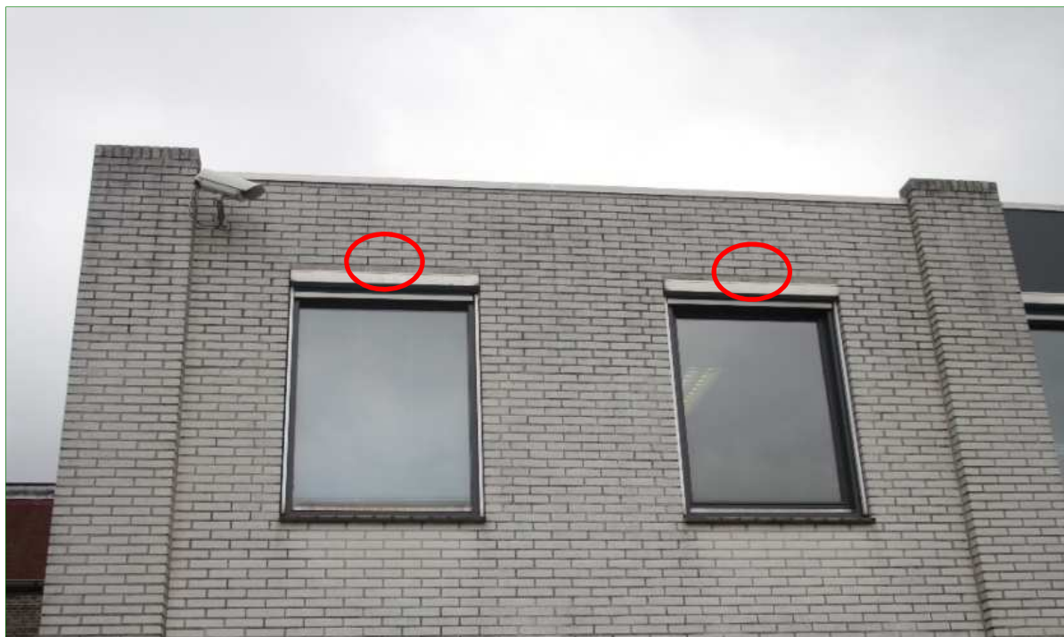
Tweede verdieping van het kantoorpand met smalle open stootvoegen.
