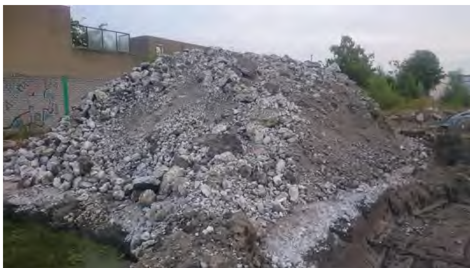
Vlek 6, foto 2 (in depot geplaatste verbrandingsslakken-/puinfundering)
