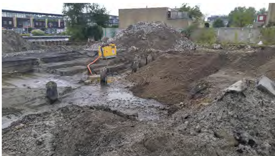
Vlek 6, foto 5 (start aanvulling schone grond t.p.v. van vlek 6)
