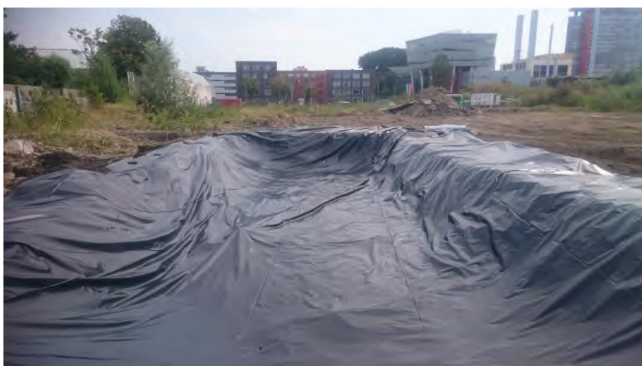
Vlek 5, foto 3 (inrichten tijdelijk depot t.b.v. opslaan VOCL grond, depot 5.D1)
