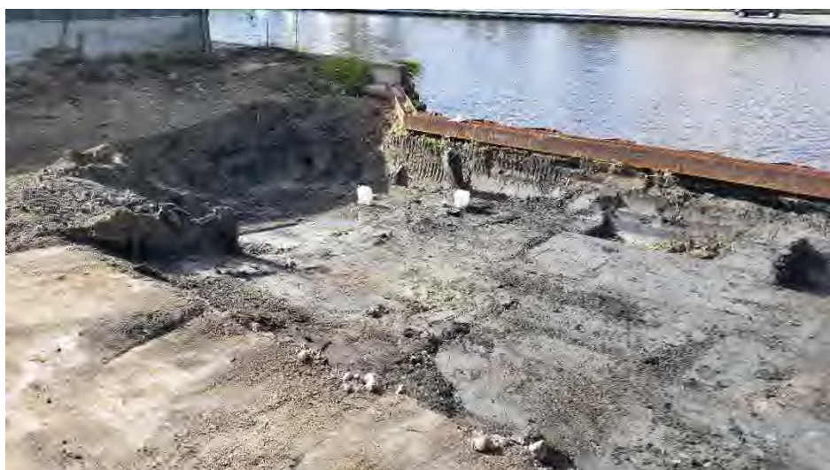
Vlek 4, foto 2 (ontgraving en gedeeltelijke aanvulling (zuidelijke deel langs damwand))
