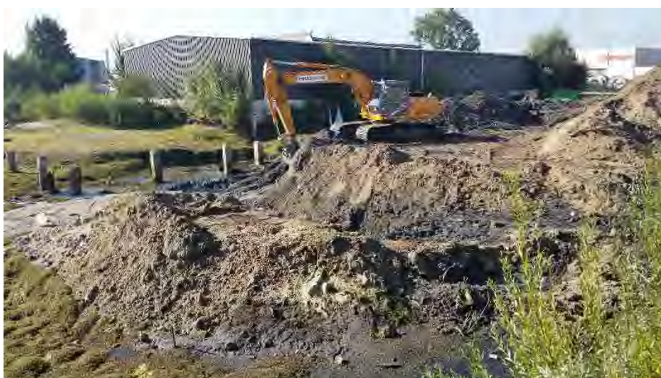
Vlek 1, foto 1 (ontgraven verontreinig en opslaan in tijdelijk depot 1.D1)
