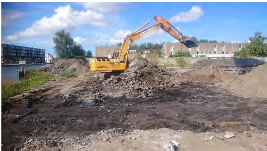
Vlek 6, foto 1 (verwijderen aanwezige verbrandingslakken-/puinfundering)
