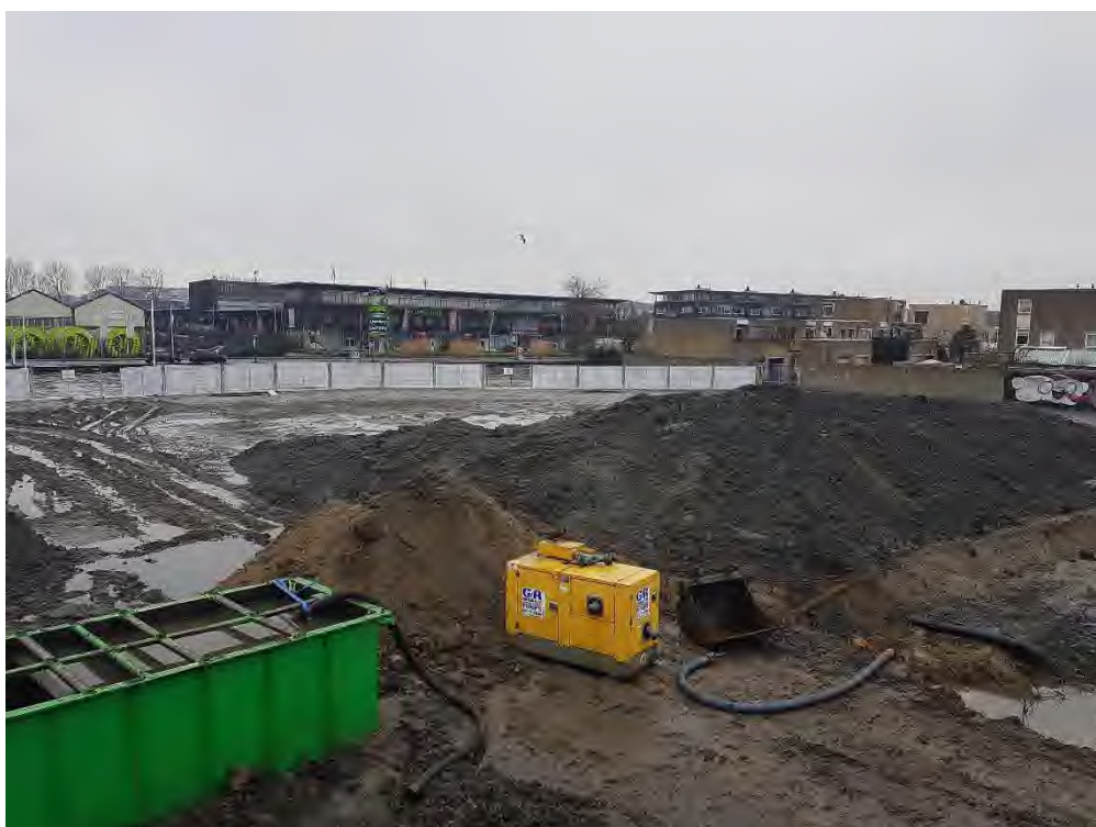
Vlek 10, foto 2 (isoleren immobiele verontreinigingen met o.a. koper, PAK, lood en asbest)
