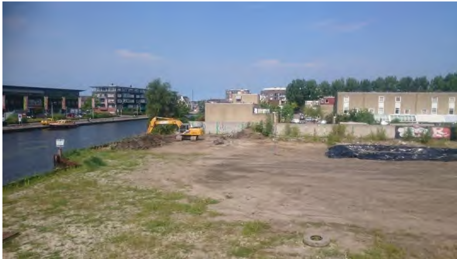
Vlek 5, foto 4 (ontgraven verontreinigde grond)
