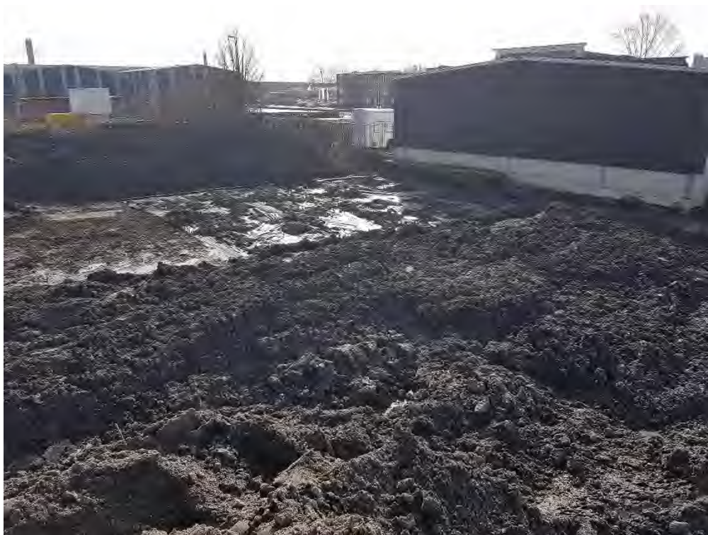
Vlek 10, foto 3 (isoleren immobiele verontreinigingen met o.a. koper, PAK, lood en asbest)
