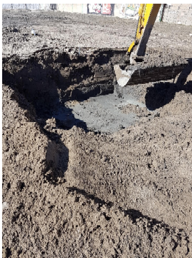
Vlek 12, foto 1 (ontgraven verontreiniging minerale olie)
