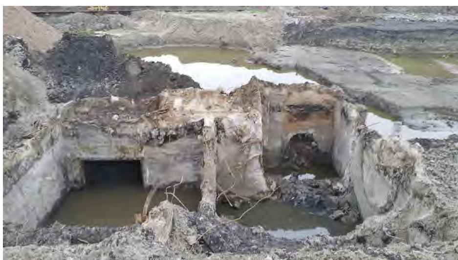
Vlek 6, foto 4 (verwijderen kelderbak ter plaatse van vlek 4)
