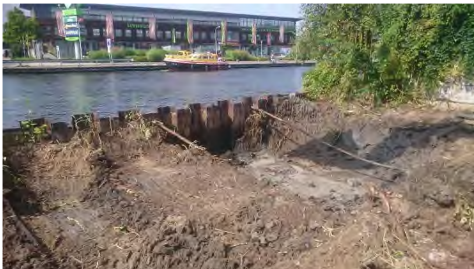
Vlek 5, foto 1 (ontgraven niet verontreinigde bovengrond)
