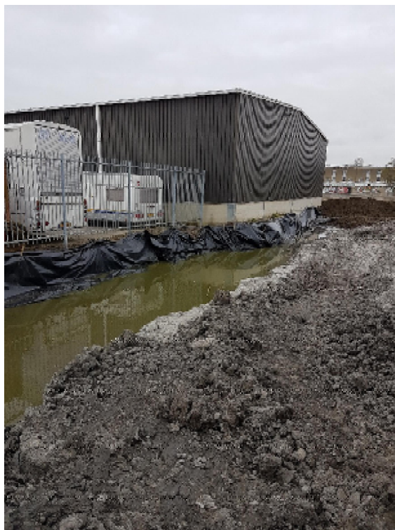
Vlek 10, foto 4 (isoleren immobiele verontreinigingen met o.a. koper, PAK, lood en asbest)
