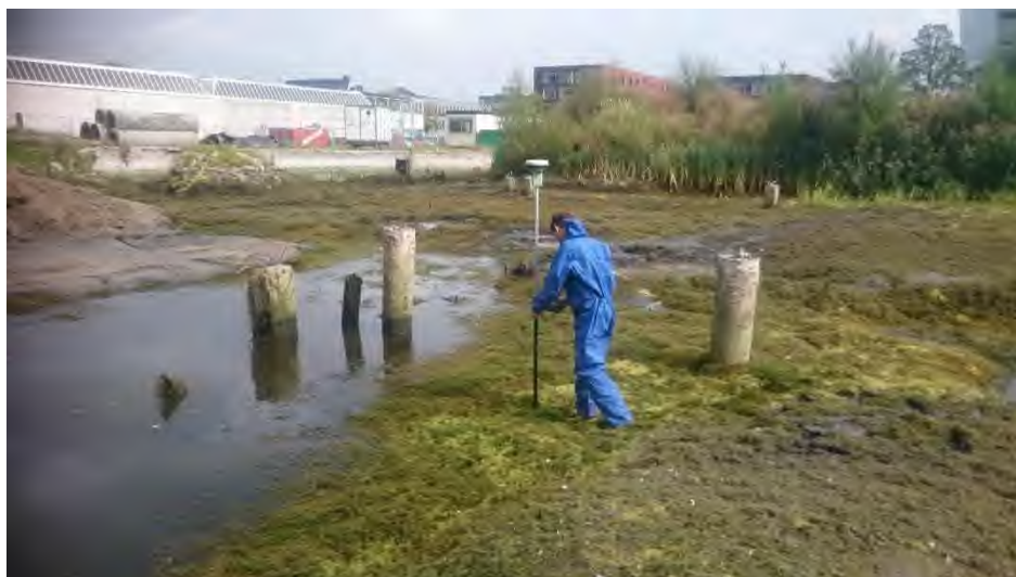
Vlek 1, foto 1 (inmeting onderzijde reeds ontgraven waterpartij en start ontgravingvlek 1)
