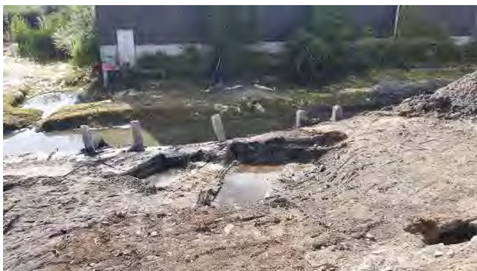
Vlek 1, foto 3 (ontgraving vlek 1, incl. plaatselijk diepere ontgraving)
