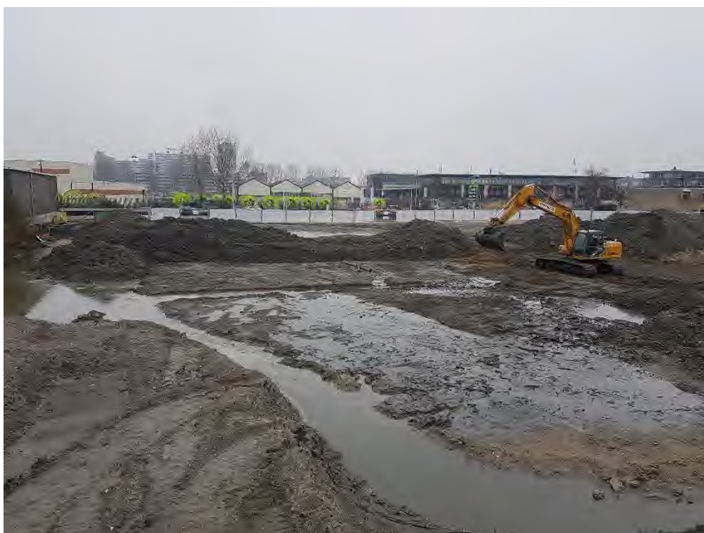
Vlek 10, foto 1 (isoleren immobiele verontreinigingen met o.a. koper, PAK, lood en asbest)
