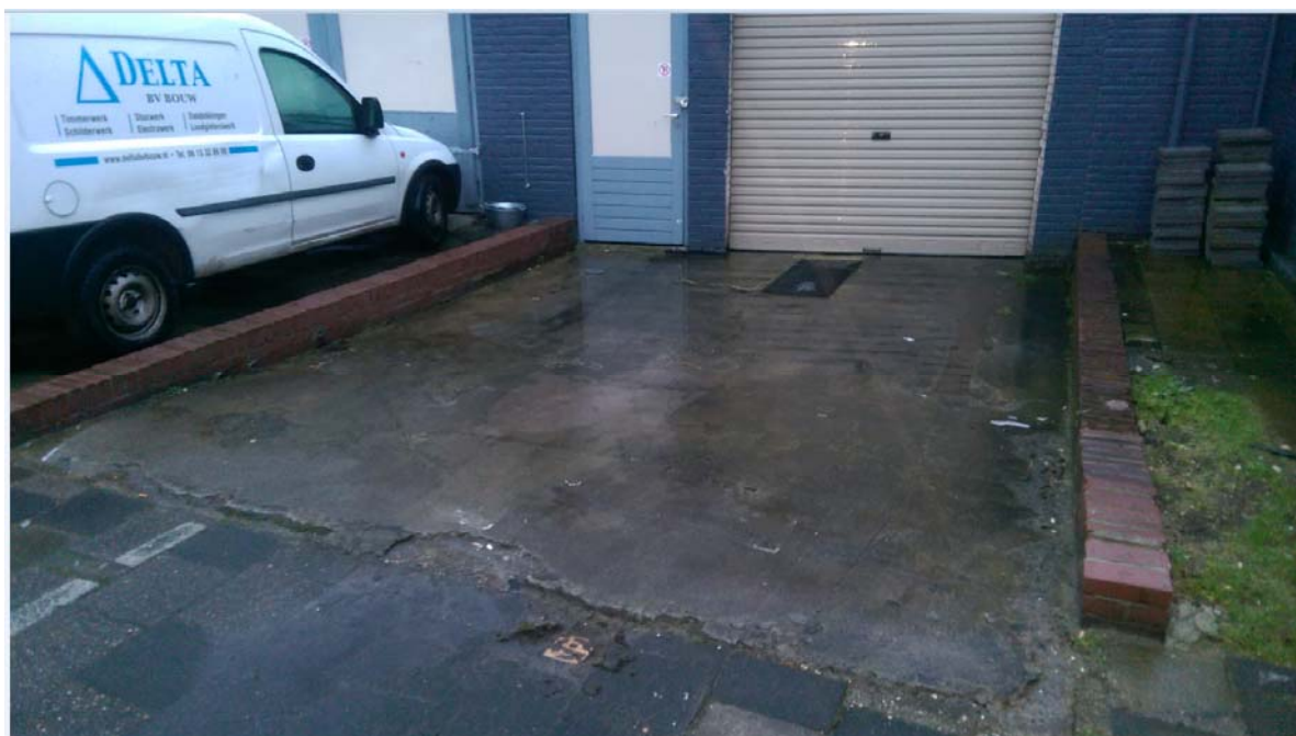
Voormalige wasplaats met peilbuis 2 (voormalige onderzoek)
