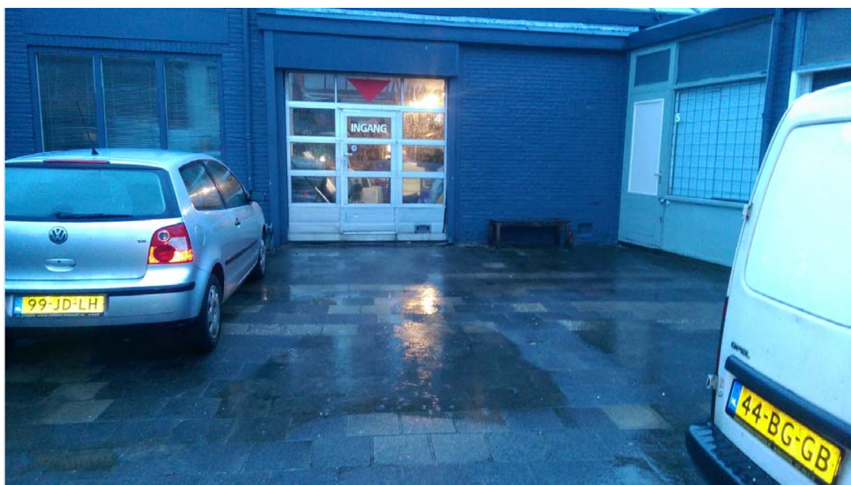
Aanzicht ingang voormalige tectyleerruimte (niet toegankelijk voor boorwerk)
