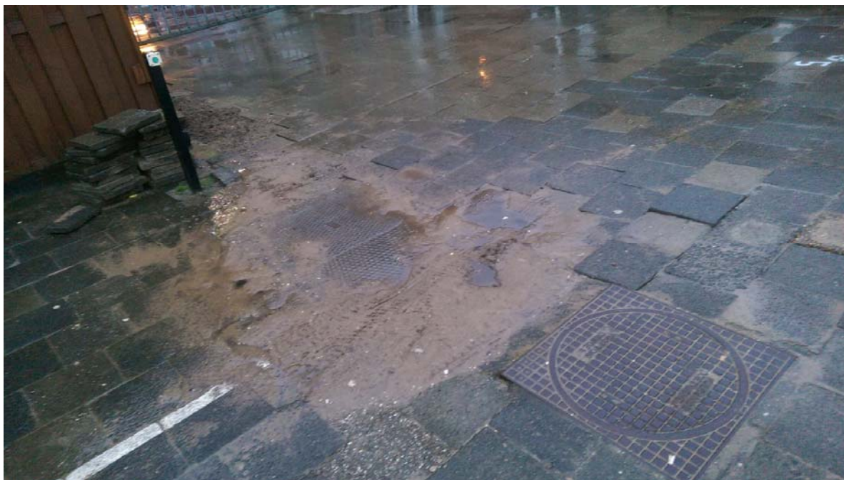
Buiten gebruik zijnde Olie-vetafscheider
