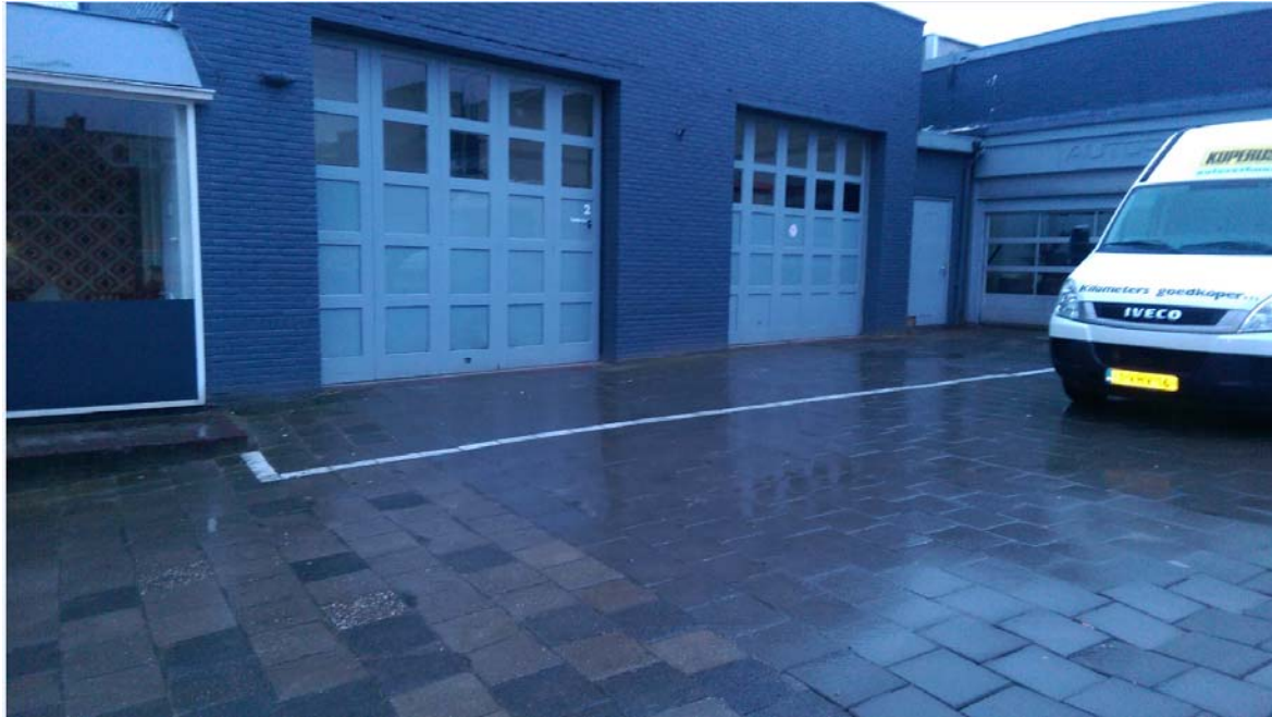
Aanzicht voormalige werkplaatsen (oostelijk en noordelijk gedeelte)
