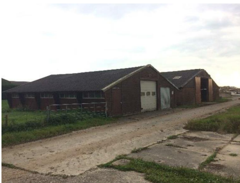
Foto 3 aanwezige te slopen opstallen
