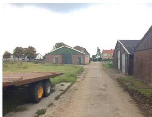
Foto 2 aanwezige te slopen opstallen
