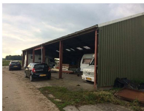
Foto 4 aanwezige te slopen opstallen
