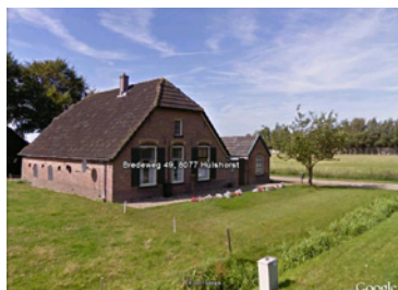
Hallehuisboerderij 1850-1910. Zadeldak met wolfseind.
