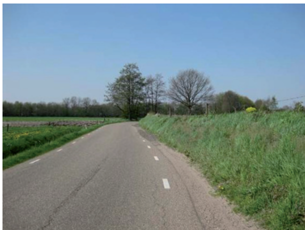
Afb. Hier bij de Bovenweg ten oosten van Nunspeet, is de opgehoogde akker goed te zien.
