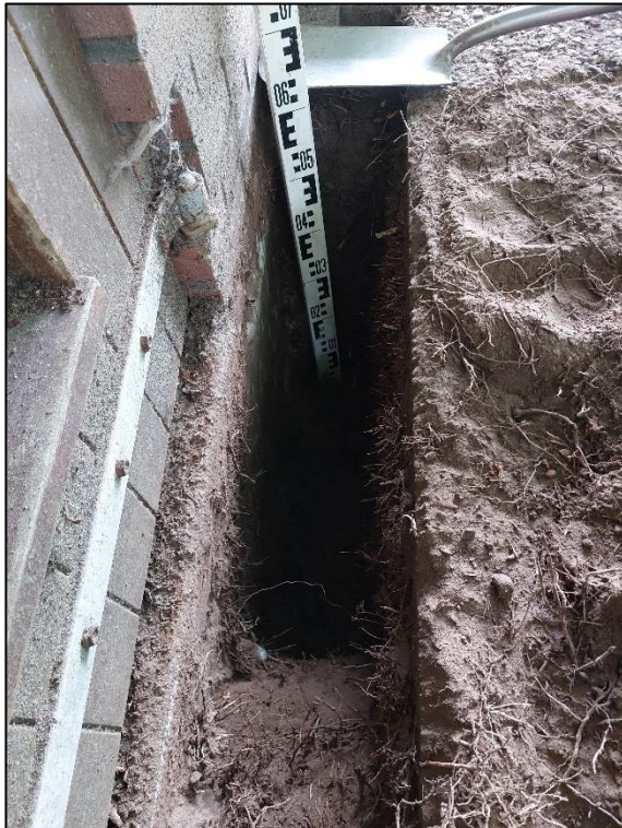
Impressie van de profielsleuf bij boom 1
