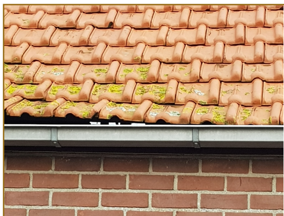
Afb. 2.11: Foto van de dakpannen van de schuur met nummer 5. Zoals te zien is, kan er onder de dakpannen door gekeken worden en is er geen geschikte ruimte voor huismussen aanwezig.
