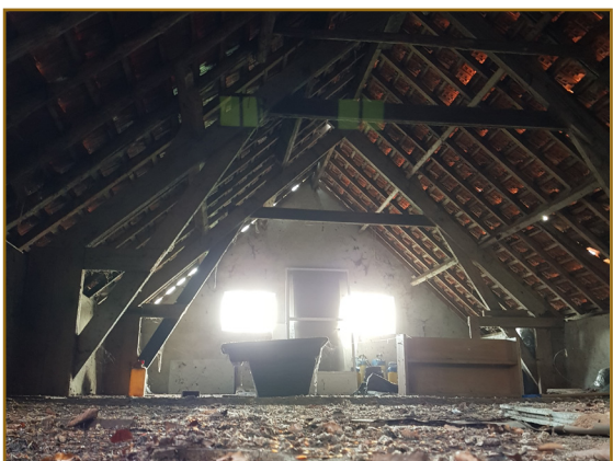
Afb. 2.12: Foto van de vloering van de schuur met nummer 5. Zoals te zien is er veel lichtinval en staan er maar enkele dingen op de vloering waar bovendien geen mogelijkheid is tot schuilen.
