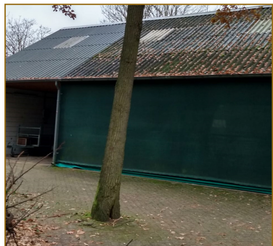
Afbeelding. 2.6: Te slopen opslagschuur.
