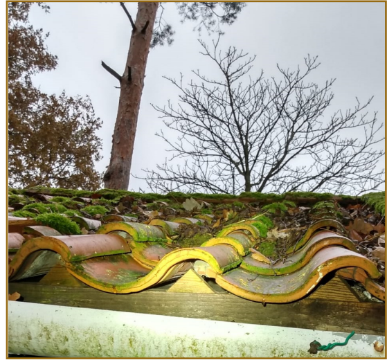
Afbeelding. 2.8: Dakpannen van recreatiewoning 35 met daaronder de driehoekige houten blokjes tegen huismussen.
