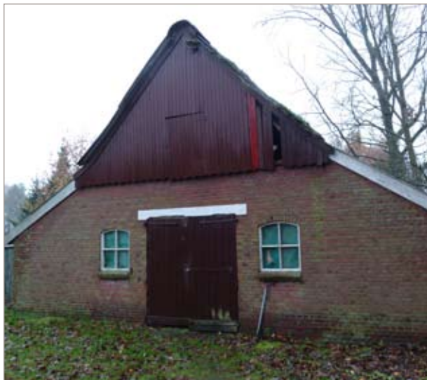
Afbeelding 16. Te slopen bebouwing
