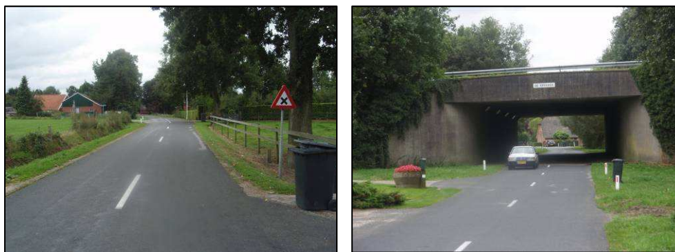
Figuren 2.2 en 2.3: Rondweg in de huidige situatie. Links ter hoogte van de aansluiting met de Mettenkampsweg. Rechts viaduct De Kruuder waarmee de Rondweg onder de autosnelweg A1 door gaat
