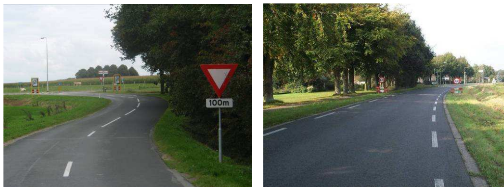
Figuren 4.4 en 4.5: Links vormgeving van de Rondweg in huidige situatie. Rechts vormgeving erftoegangsweg buiten de bebouwde kom met een gemengd profiel
