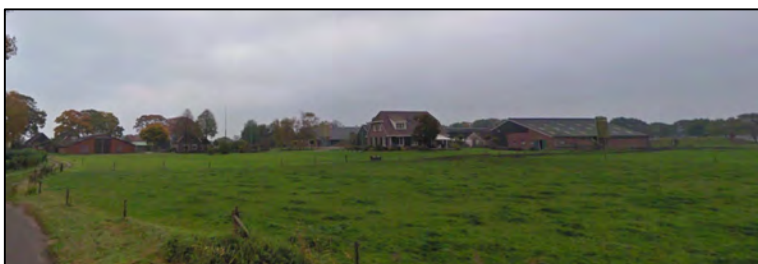
Figuur 8 Te slopen opstallen (vanaf de Larinksmars)
