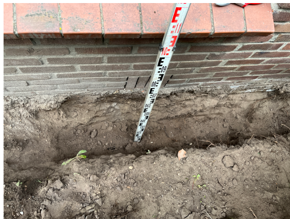
Afbeelding 11: Proefsleuf langs de fundering
