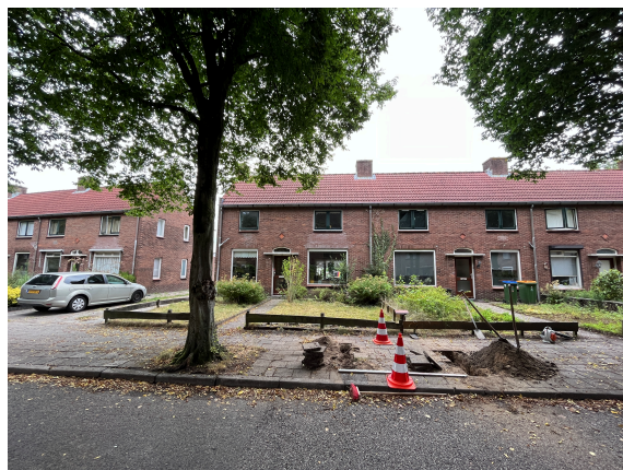
Afbeelding 8: Proefsleuf bij boom 105
