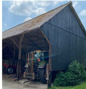
Bestaande kapschuur op het erf
