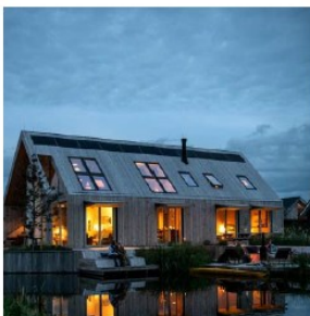
Terugkerende gevelopeningen in de zijgevels
