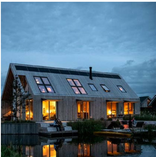
Terugkerende gevelopeningen in de zijgevels
