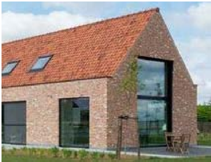
Terugkerende gevelopeningen in de zijgevels
