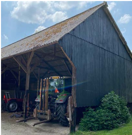
Bestaande kapschuur op het erf
