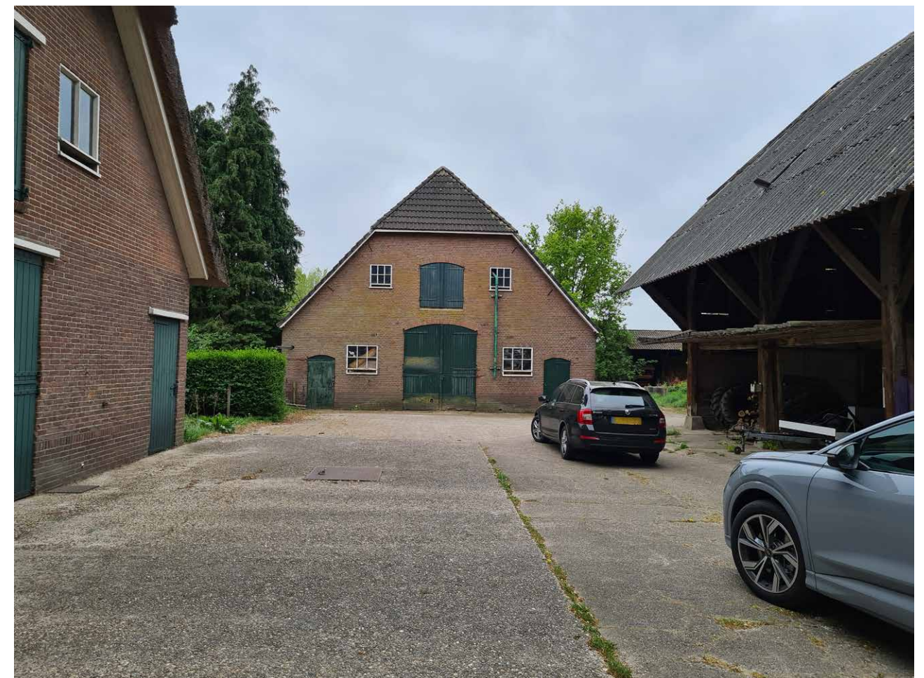
Bestaande bebouwing op het historisch erf behouden
