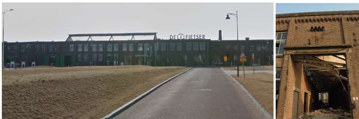
Figuur 13: zicht vanaf de AKU-laan op de herbestemde westvleugel van de oude Enka fabriek, met aan het einde van de zichtas één van de twee treindoorgangen (met bovengelegen stoplichten) vóór de restauratie.
