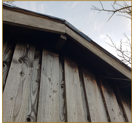
Afbeelding 2.8: Impressie van gebouw 6. Er zijn geen openingen aangetroffen die beschermde soorten zouden kunnen gebruiken.
