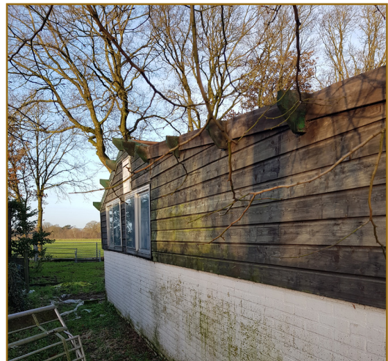
Afbeelding 2.4: Zuidelijke zijde van gebouw 1.
