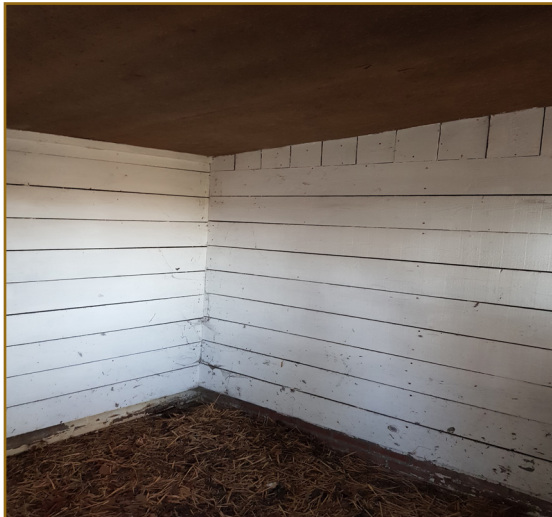
Afbeelding 2.9: De binnenzijde van schuur 5. Er zijn geen openingen voor beschermde soorten om binnen te komen en ook zijn er geen sporen aangetroffen.
