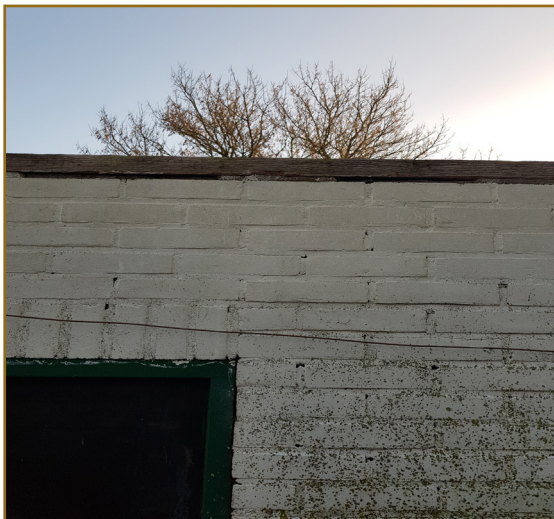
Afbeelding 2.3: Gebouw 1. De houten balk bovenop de muur met daartussen mortel sluit de toegang tot de luchtpouw af.
