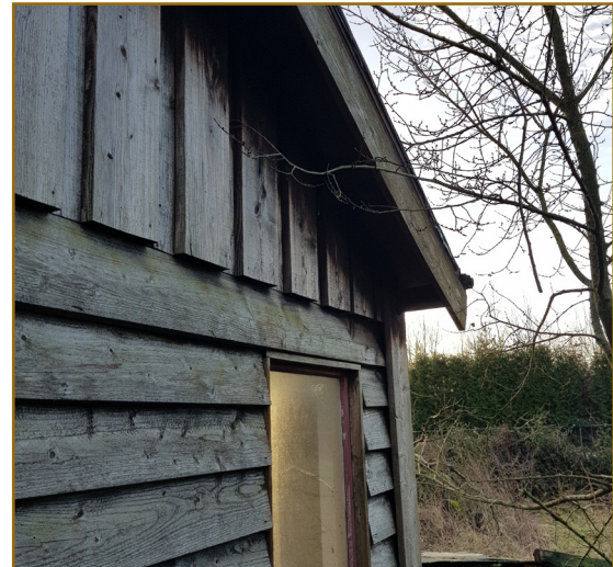
Afbeelding 2.10: Kopse kant van schuur 6. Geen opening voor huismussen, vleermuizen of andere beschermde soorten.
