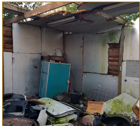
Afbeelding 2.6: Binnenkant van gebouw 3. De dakbedekking is deels weg en daarom is de schuur erg licht en tochtig.
