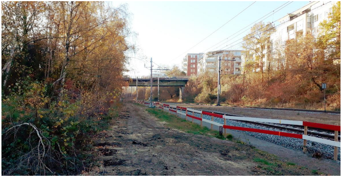
Afbeelding 1.3.3: Het westelijke deel van het plangebied. Duidelijk te zien is dat de spoorlijn diep is ingegraven ligt. Het viaduct is van de Streeperkerstraat. De strook met omgewerkte grond langs de spoorlijn is ontstaan bij recente graafwerkzaamheden (november 2018).
