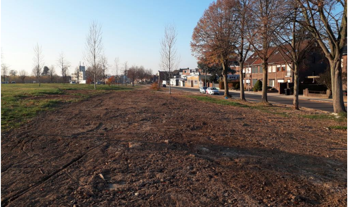
Afbeelding 1.3.3: Recent afgeronde graafwerkzaamheden in een brede strook langs de Spoordamstraat. De strook ligt deels in het plangebied. De foto is gemaakt van nabij boring 15, kijkende in noordwestelijke richting (november 2018).
