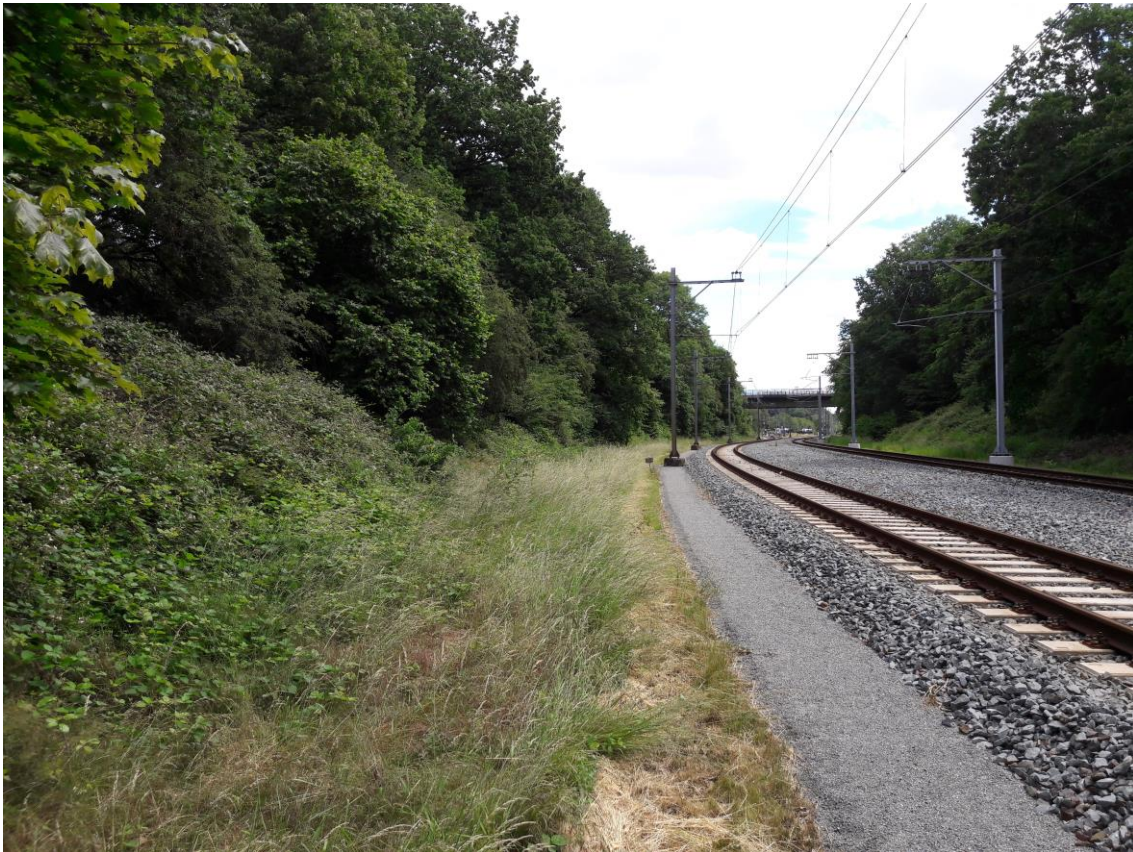
Figuur 3 Gemaaide berm aan de noordzijde van het spoor in de buurt van tegel 2.
