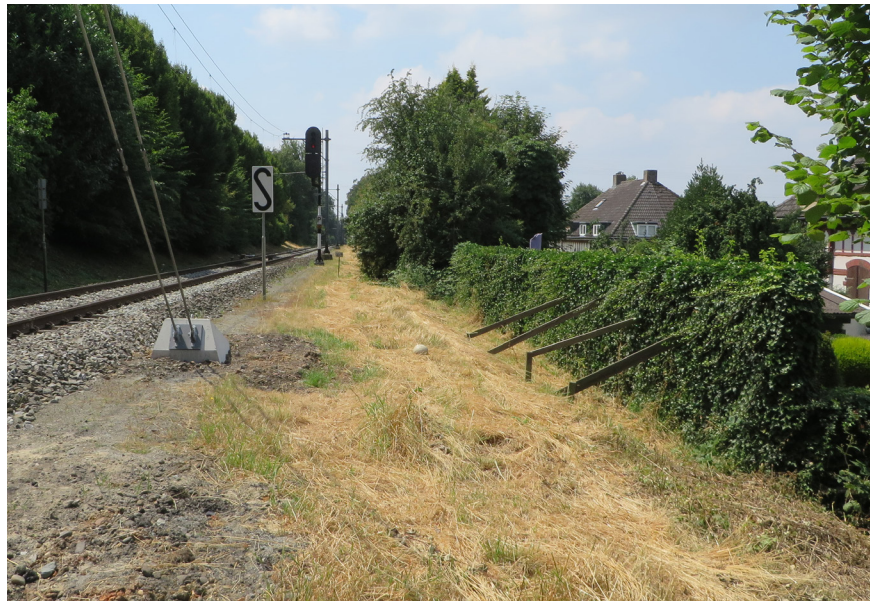
Huidige situatie: Spoor met talud, rechts liggen de tuinen
