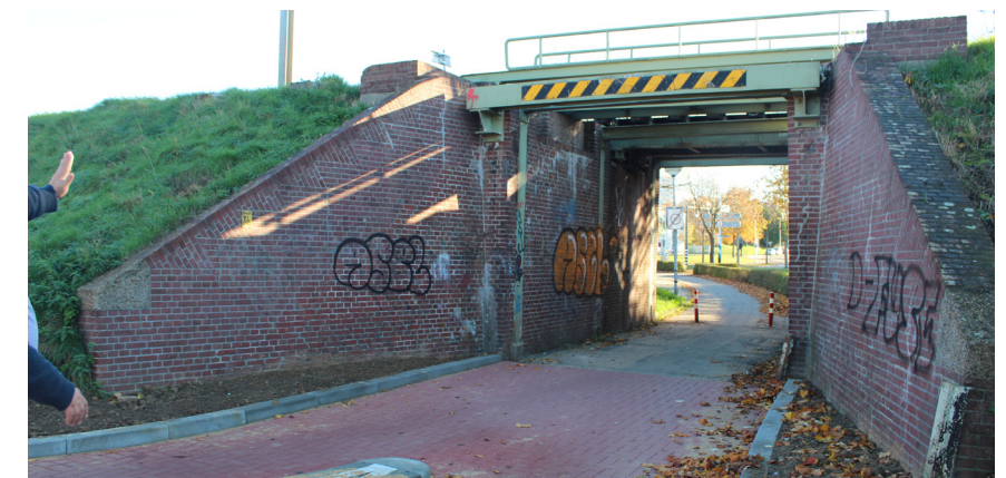
Huidige situatie: Historische onderdoorgangen afgewerkt met (sier) metselwerk
