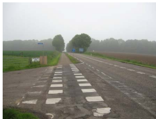
Figuur 4: De N598 ter hoogte van Termaar. Het bos op de achtergrond markeert de Vosgrubbe.
