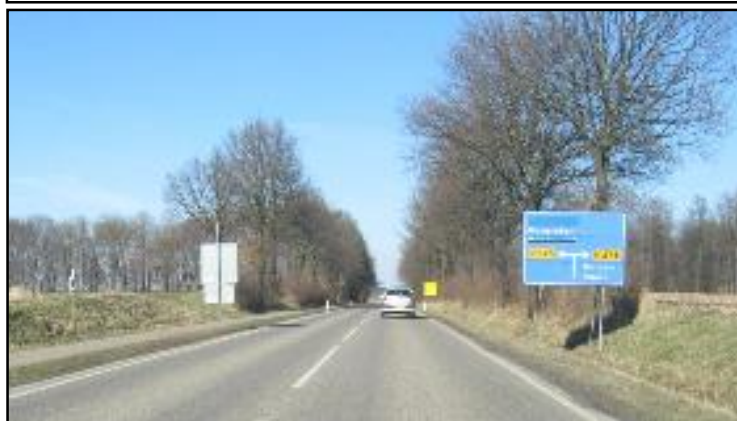
Fig. 35. Links: N598 ter hoogte van Termaar richting kruising 'De Hut'.
