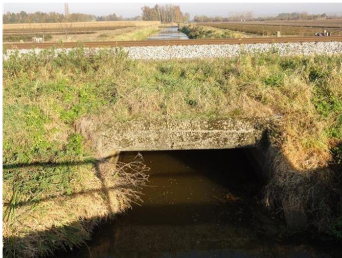
Figuur 1 Foto uit inspectierapport 2011
