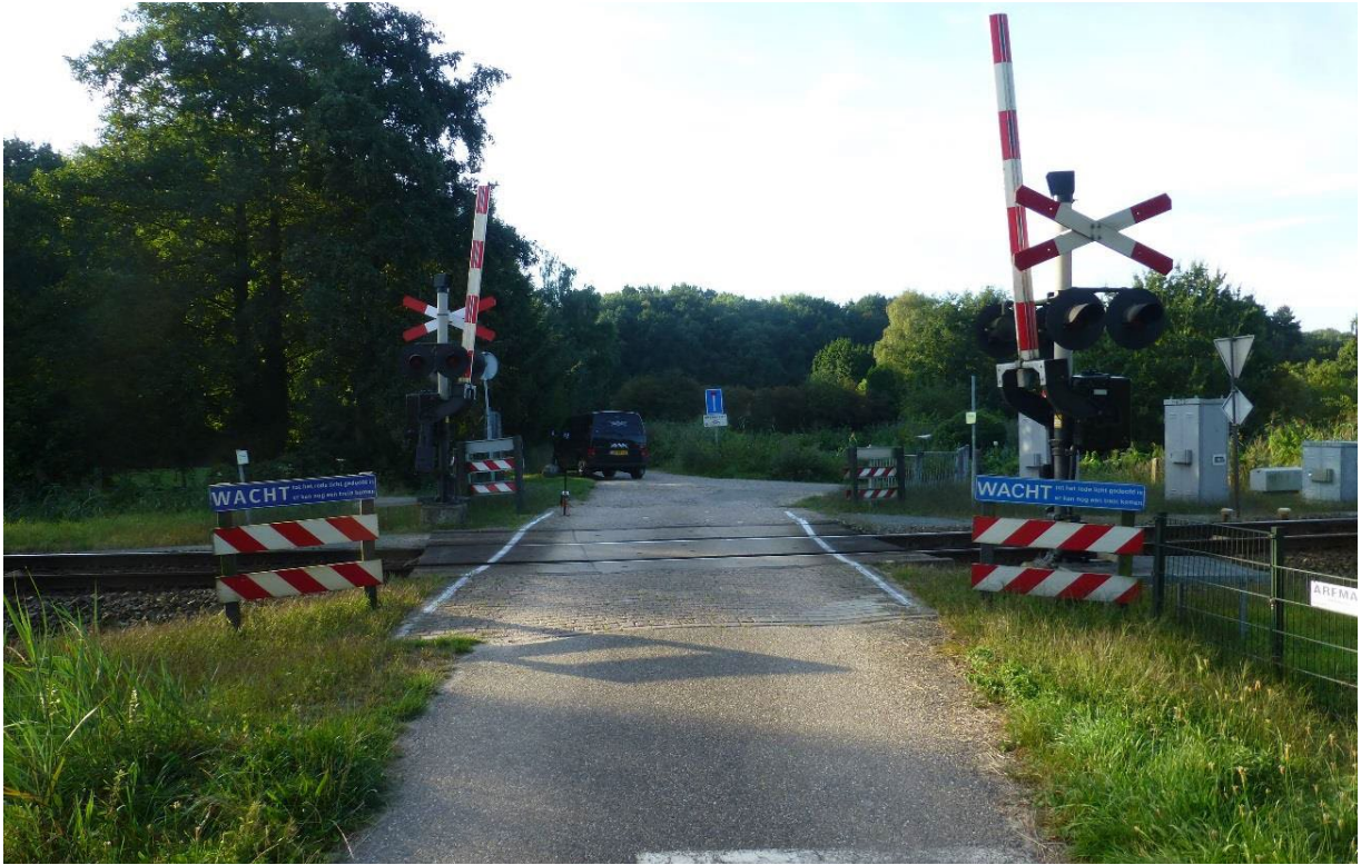
Figuur 4-11: Situatiefoto overweg Voerdijk, Venlo
