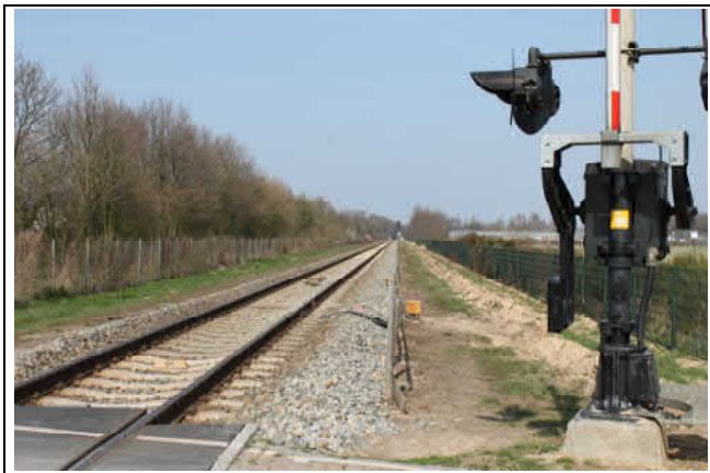
Spoorbaan richting Venlo, vanaf de overgang met de Bussereindseweg
