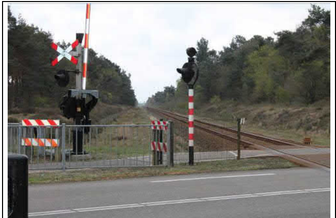
Spoorbaan richting Venray-Venlo, vanaf de overgang Maasheseweg
