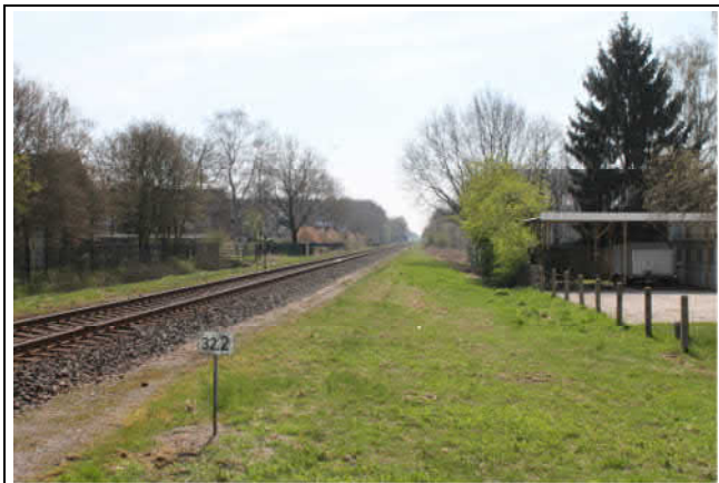
Spoorbaan richting Venlo, vanaf de overgang met de Hapsebaan
