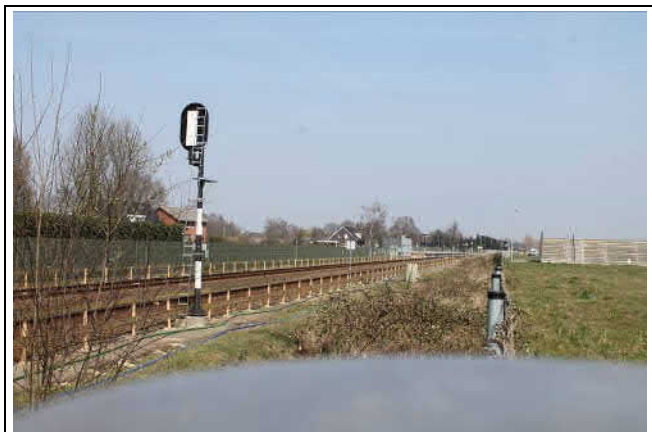
Spoorbaan richting halteplaats Swalmen van bovenaf de Swalmentunnel
