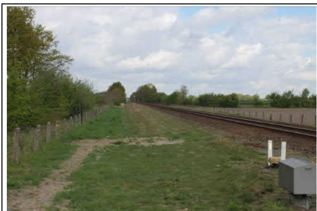
Spoorbaan richting Nijmegen, vanaf de overgang met de Horsterdijk
