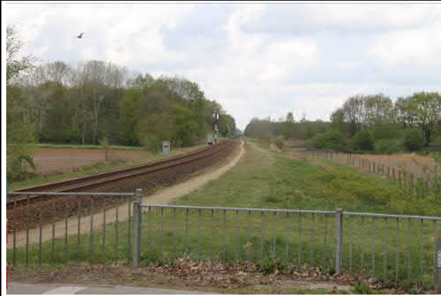
Spoorbaan richting Venray-Nijmegen, vanaf de overgang Spoorstraat
