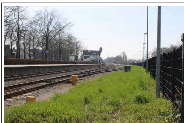
Zicht op station Cuijk, vanaf de overgang Beersweg
