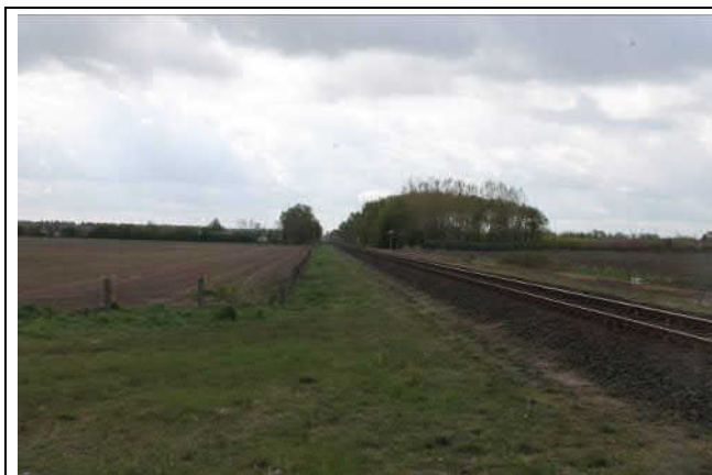
Spoorbaan richting Venlo, vanaf de overgang met de Broekhuizerdijk
