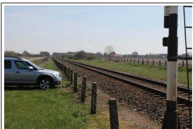
Spoorbaan richting Venlo, voormalig emplacement Sambeek (Radioweg)
