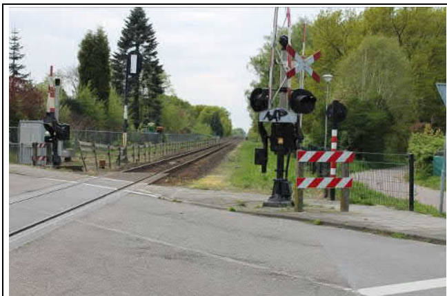
Spoorbaan richting Roermond, vanaf de overgang met de Steenstraat
