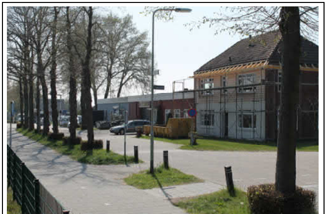
Gesaneerde locaties Lindenlaan, omgeving Asfaltplatenfabriek (Vexma)
