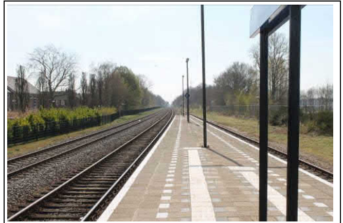
Spoorbaan richting Venlo, zicht vanaf het perron (station Cuijk)
