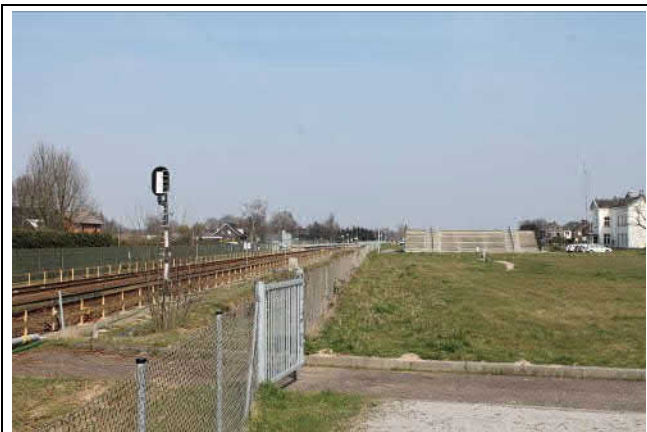
Zicht op oude station (rechts) en nieuwe halte plaats Swalmen
