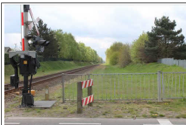
Voormalig emplacement Grubbenvorst, vanaf overgang Kloosterstraat
