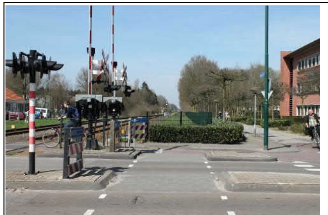
Spoorbaan richting Cuijk-Nijmegen, vanaf de overgang Sint Antonisweg
