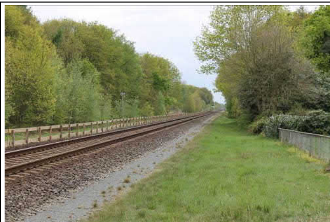
Spoorbaan richting Venlo, vanaf de overgang met de Patersveld
