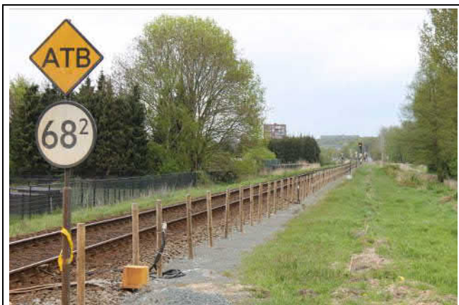
Spoorbaan richting Venlo, vanaf de overgang Egypte
