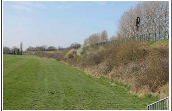
Spoordijk richting Cuijk-Venlo, zicht vanaf de Everdingeweerd
