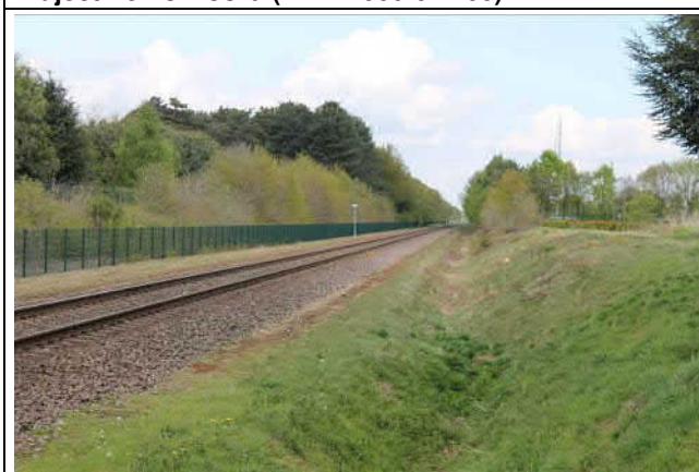
Spoorbaan richting Nijmegen, vanaf de overgang met de Sint Jansweg
