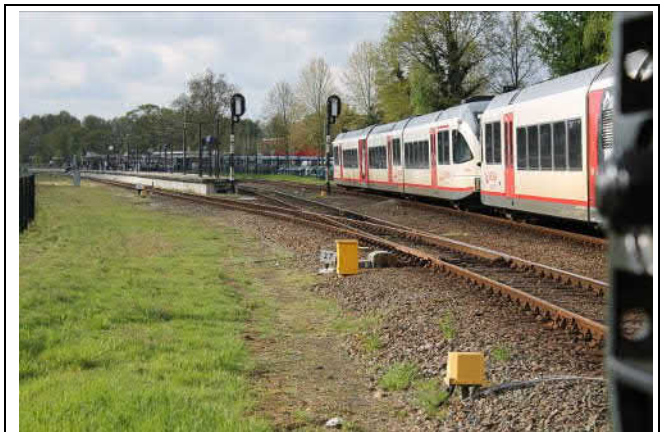
Emplacement en station Venray, vanaf overgang Monsieur Hanssenstraat
