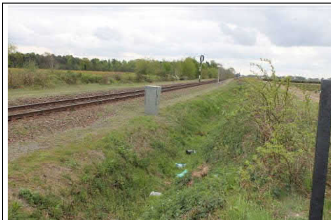
Spoorbaan richting Venlo en greppel (zwerfafval), vanaf de Herenbosweg
