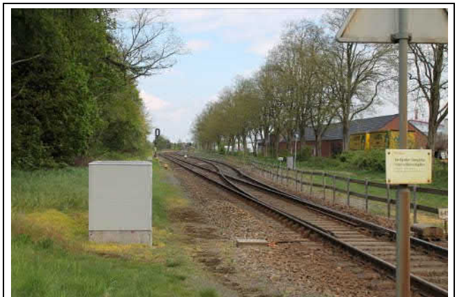
Voormalige emplacement Tegelen, vanaf de overgang met de Steenstraat
