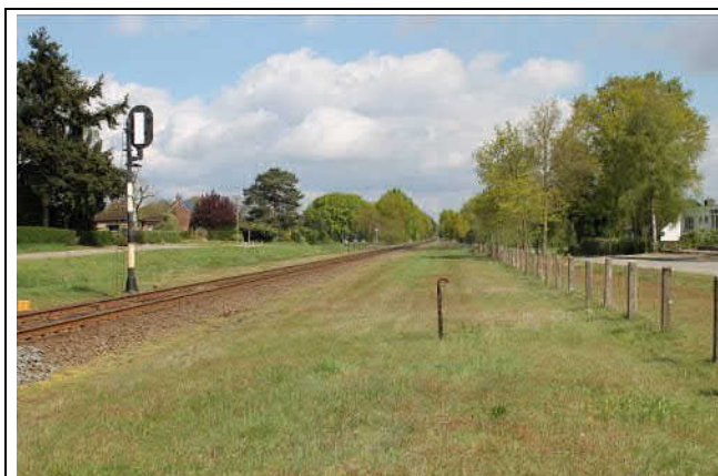
Voormalig emplacement Grubbenvorst, vanaf overgang Kloosterstraat
