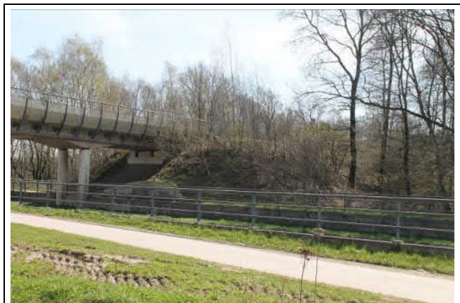
Spoorviaduct over de Oeffeltseweg
