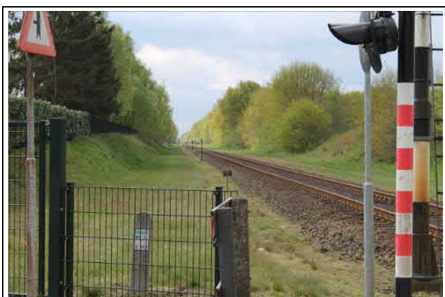
Voormalig emplacement Grubbenvorst, vanaf overgang Kloosterstraat
