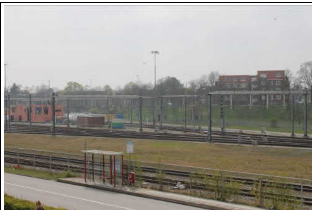
Tankplaats in de spoorkuil, vanaf de Doktor Jan Berendsstraat
