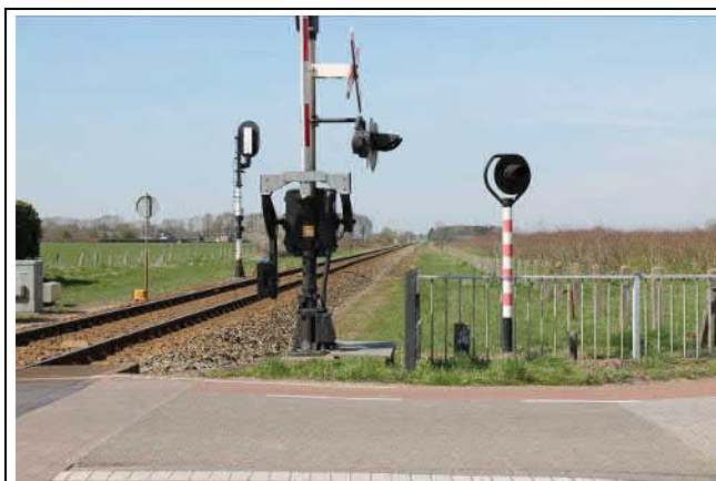
Spoorbaan richting Nijmegen, voormalig emplacement Sambeek (Radioweg)
