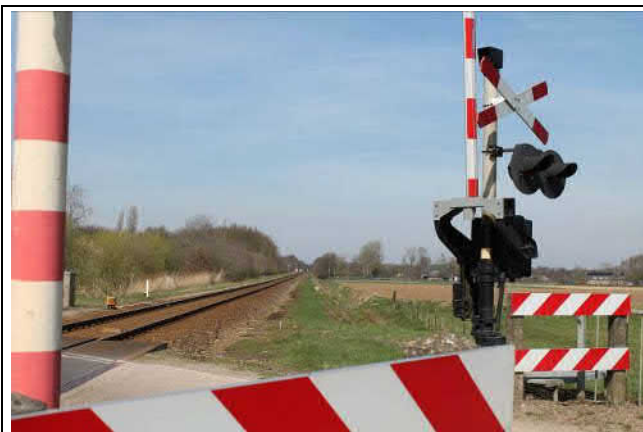
Spoorbaan richting Cuijk-Nijmegen, vanaf de overgang Heiveldseweg
