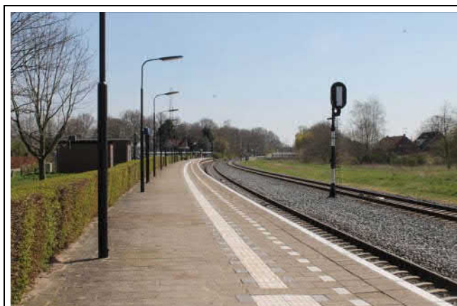
Spoorbaan richting Venlo, vanaf het perron station Vierlingsbeek
