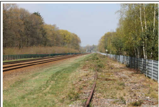
Spoorbaan richting Nijmegen, vanaf overgang Sionsweg (oude spoorbaan)
