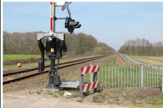
Spoorbaan richting Cuijk-Nijmegen, vanaf de overgang Hertriksestraat
