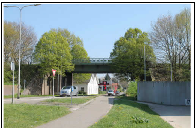
Verhoogde ligging spoorbaan richting Venlo, over de Rijksweg N271
