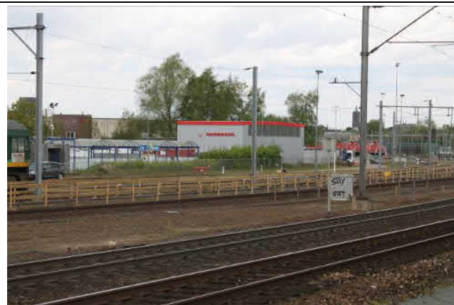
Emplacement Venlo en vml. werkplaats (nu: afspuitplaats en bandenhotel)
