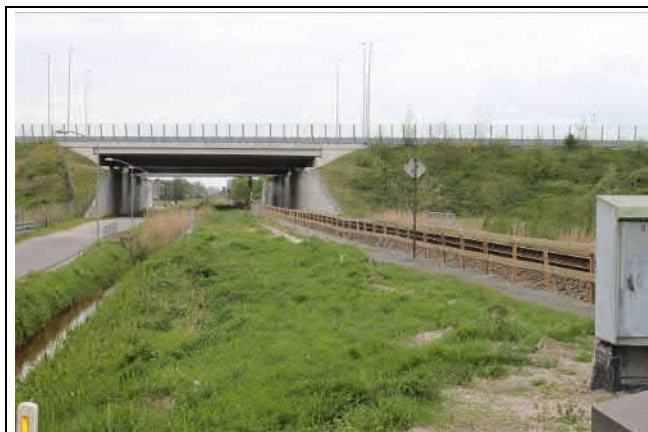
Spoorbaan richting Roermond en viaduct A74, vanaf de overgang Egypte
