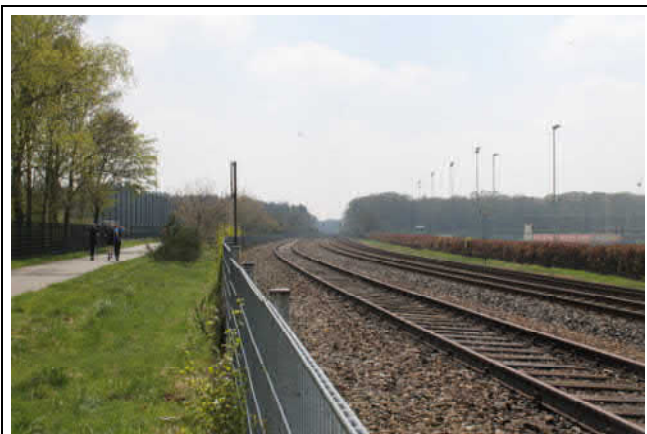
Spoorbaan richting Venlo, vanaf de overgang D'Almarasweg
