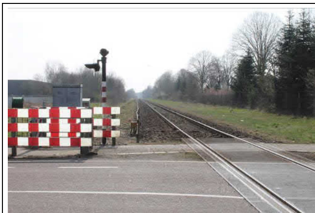
Spoorbaan richting Roermond, vanaf de overgang met de Sint Josefweg
