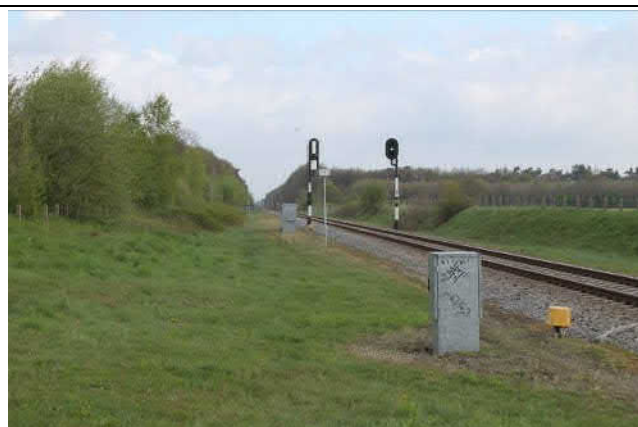
Spoorbaan richting Boxmeer-Nijmegen, vanaf de overgang Rosmolenweg
