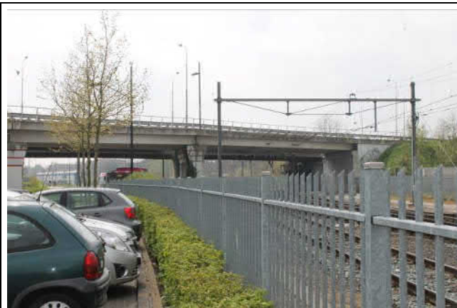
De campusbaan over de dieselspoorbaan, vanaf parkeerplaats ROC
