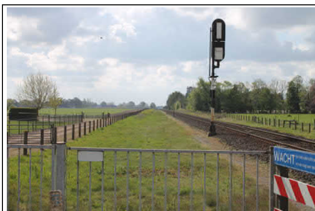
Spoorbaan richting Venlo, vanaf de overgang Gunhoekweg
