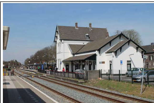
station Boxmeer, zicht vanaf het perron
