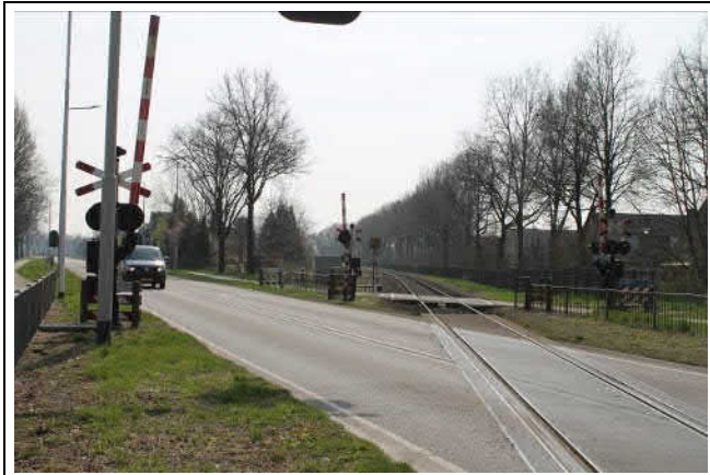
Spoorbaan richting Roermond, vanaf de spoorovergang met de Rijksweg
