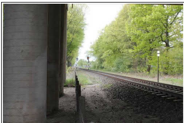
Spoorbaan richting Venlo, vanaf Grubbenvorsterweg (onder A67)
