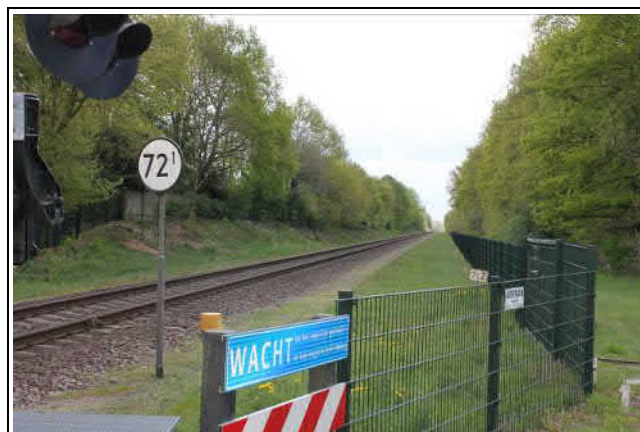
Spoorbaan richting Venlo, vanaf de overgang met de Brandakkersweg
