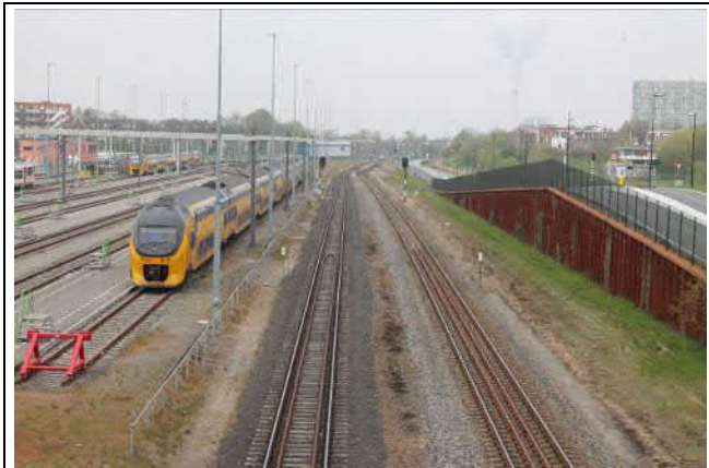
De spoorkuil met dieselspoorbaan, vanaf de Sint Annastraat
