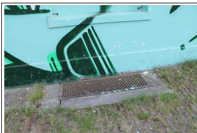
Vermoedelijk een kolenluik naast het vroegere stationsgebouw
