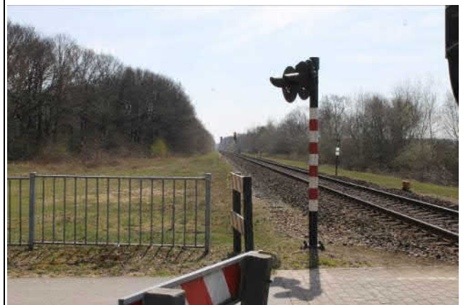
Spoorbaan richting Venlo, vanaf de overgang Hertriksestraat
