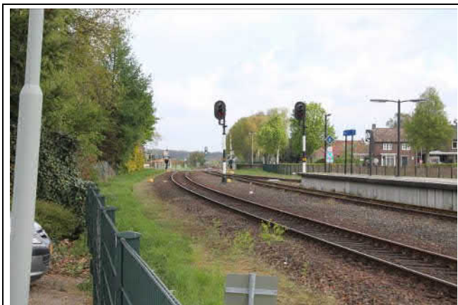
Zicht vanaf P+R op station en geval 00114.WG1 (olie onder spoorbanen)
