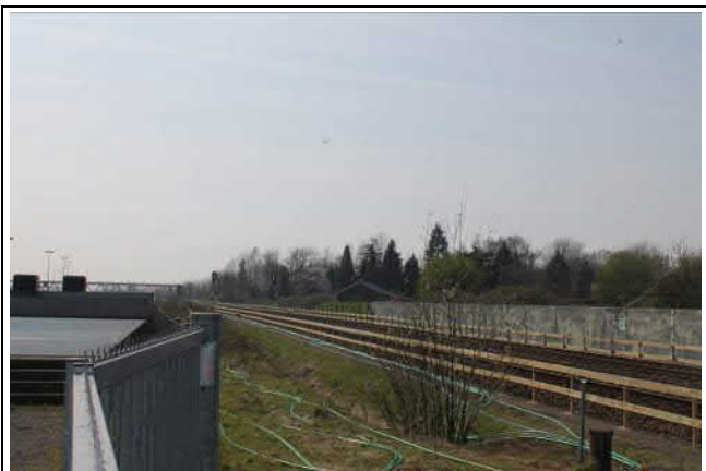
Spoorbaan richting Roermond van bovenaf de Swalmentunnel
