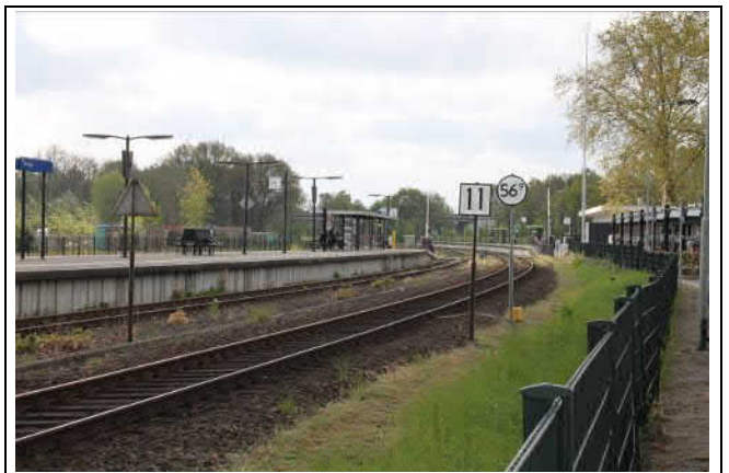
Zicht vanaf P+R op station en geval 00114.WG1 (olie onder spoorbanen)
