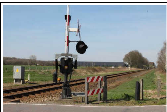
Spoorbaan richting Nijmegen, vanaf de overgang met de Peelweg
