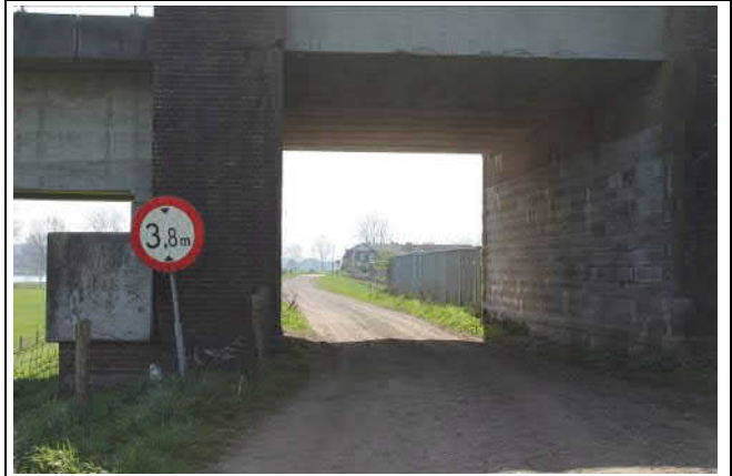
Onder de spoorbrug is een puinpad aanwezig (Everdingeweerd)
