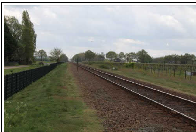
Spoorbaan richting Venlo, vanaf de overgang met de Swolgensedijk
