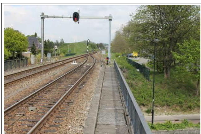
Spoorbaan richting Venlo, vanaf het perron station Tegelen
