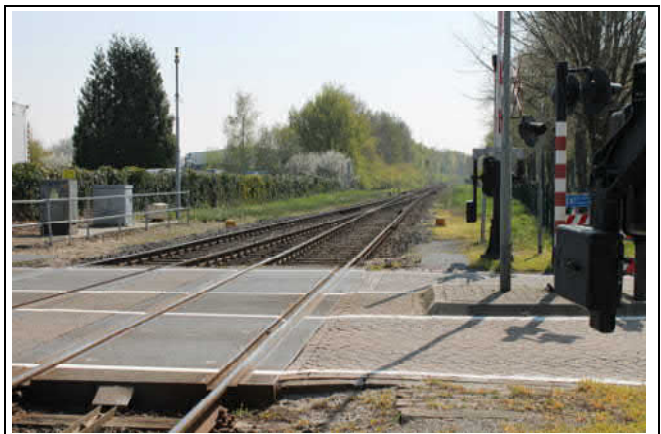
Spoorbaan richting Venlo, vanaf de overgang Bovensteweg
