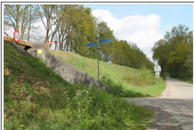
Spoorbaan richting Nijmegen (verhoogde ligging), vanaf de Broekeindweg
