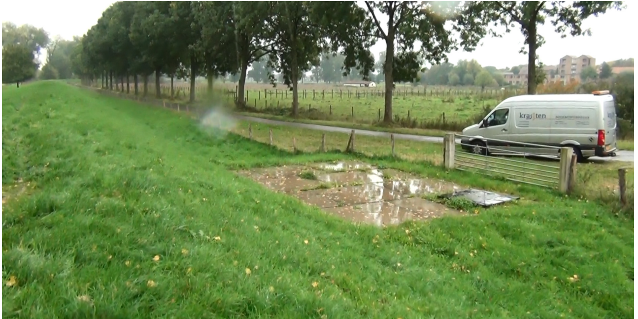
Afbeelding 6: Dijkvak 50.550.11 met rechts de Kempstraat. Op de achtergrond zijn de gronden van Hotel-Restaurant de Roosterhoeve te zien
