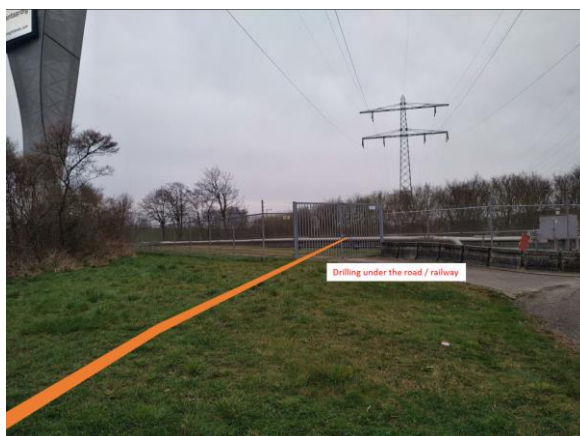
Figuur 2.12: onderdoorgang spoorweg Chemelot
