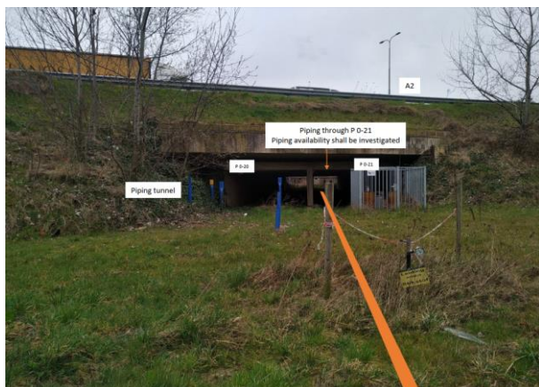
Figuur 2.11: onderdoorgang A2
