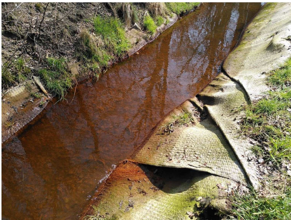
Figuur 2: Detail van de KS70 op het traject waar met bentoniet versterkt geotextiel is geplaatst. Op de naad is een lek te zien waar ijzerhoudend kwelwater tussendoor stroomt.
