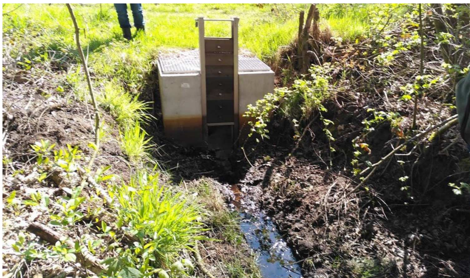
Figuur 7: Stuw in de afvoersloot op 23 april 2021, die inmiddels geheel open is gezet. Zichtbaar is dat het water inmiddels de stuw kan bereiken en door de geopende stuw weg kan stromen.
