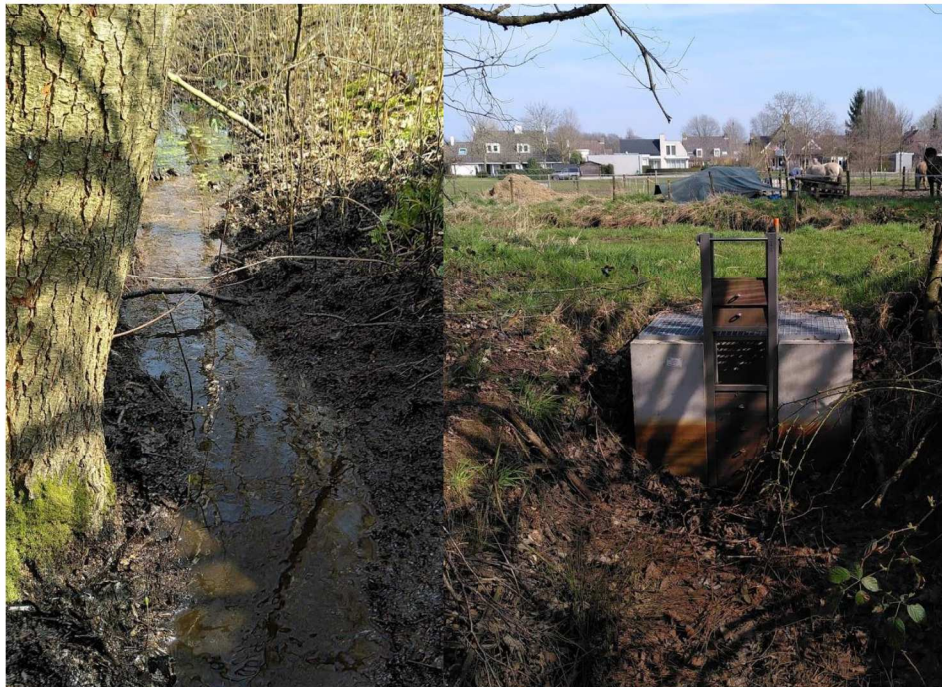
Figuur 6: Links de verbindingssloot van de laagte met de Keersop, die volstroomt na het handmatig verwijderen van wat blad en takken. Rechts het nog droge oosteinde bij de stuw op 24 maart 2021, waarop wel ijzerafzettingen te zien zijn. Ook staat de stuw ruim 20 cm hoger afgesteld dan de hoogste ijzerafzetting.
