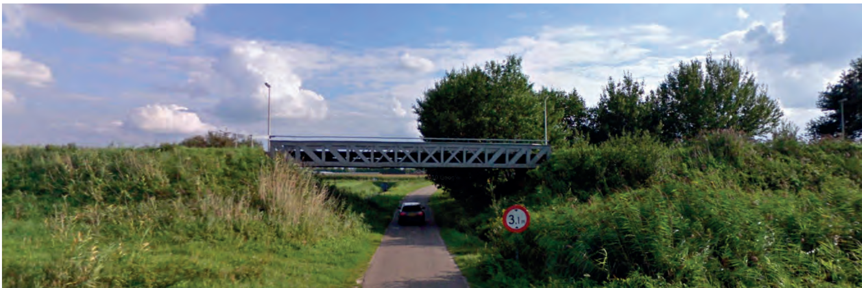
Bestaande onderdoorgang overstortweg - spoordijk gezien vanaf de noordzijde, nieuwe weg ligt aan de linkerzijde.
