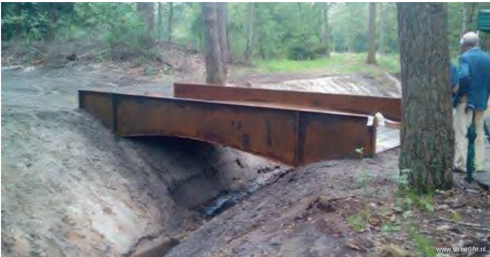
Brug van cortenstaal
