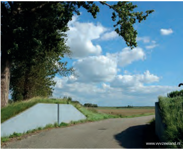
Doorsnijding dijklichaam d.m.v. een coupure
