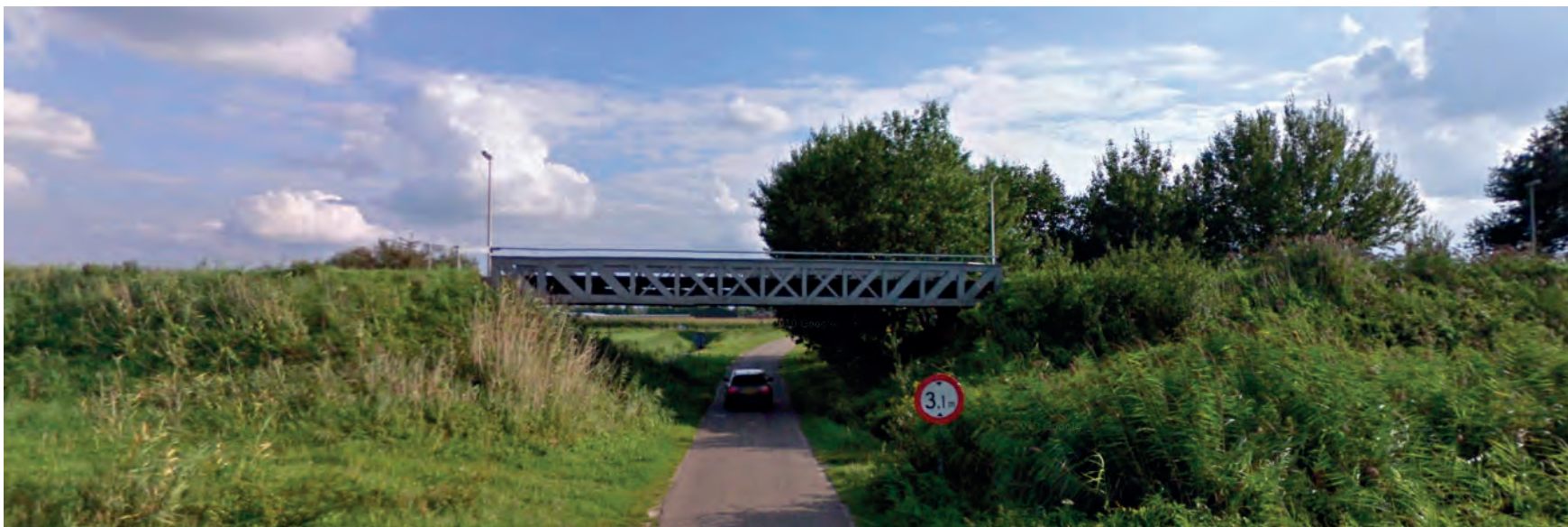
Bestaande onderdoorgang overstortweg - spoordijk gezien vanaf de noordzijde, nieuwe weg ligt aan de linkerkant.
