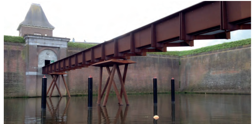
brug van weervast staal
