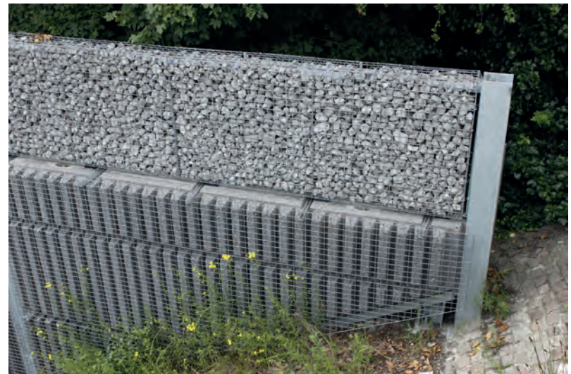
geluidsscherm van betonelementen met staal maken begroeiing mogelijk
