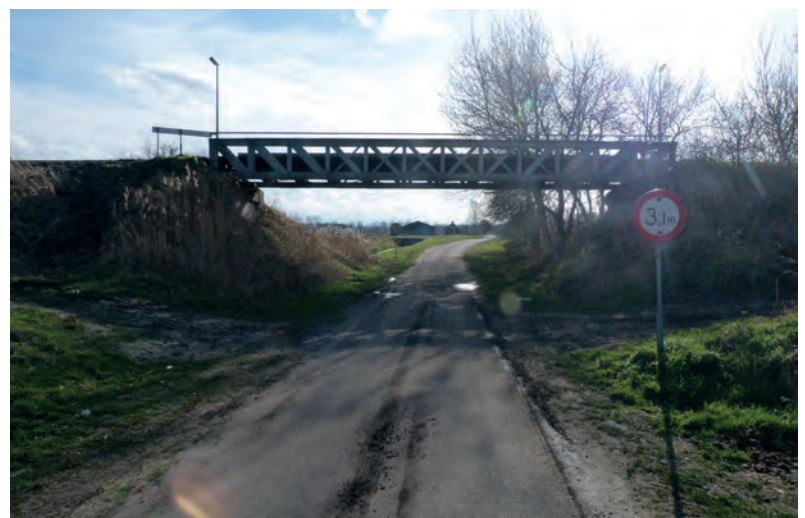
Huidige onderdoorgang Spoordijk
