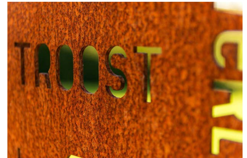
VOORBEELD TEKST MET LASERSTRAAL GESNEDEN UIT CORTENSTAAL
