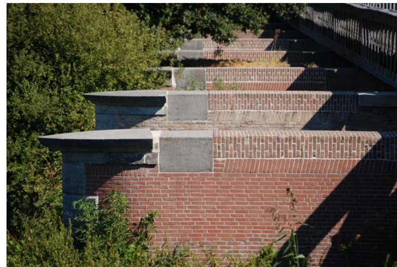
AFDEKPLATEN PIJLERS DRONGELEN KANAAL
