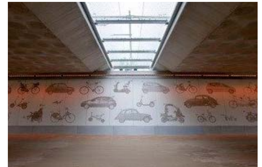
REFERENTIE: FOTO-BETON FIETSTUNNEL NABIJ MAASTRICHT
