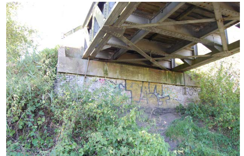
LANDHOOFD BRUG OVERTORTWEG
