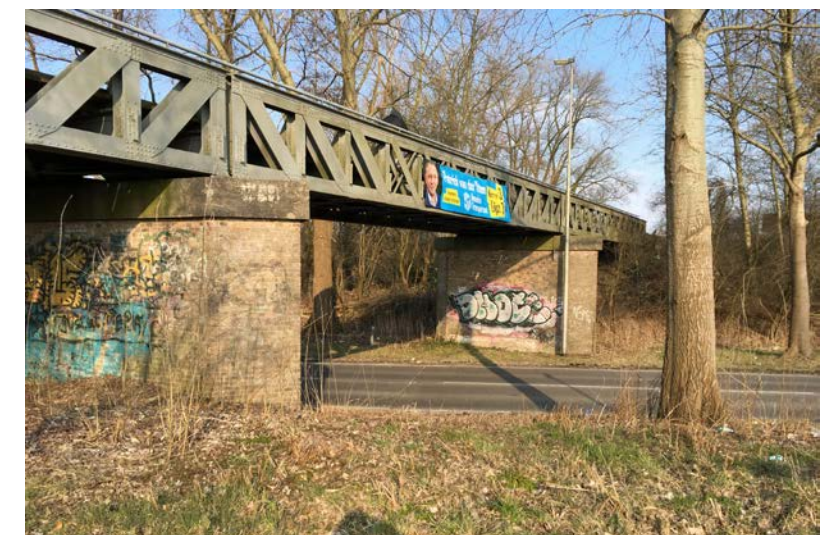
BESTAANDE PIJLERS KW4
