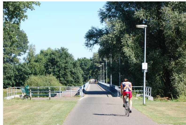
HET WESTELIJK LANDHOOFD: ENTREE VAN DE OVERLAAT VANUIT WAALWIJK
