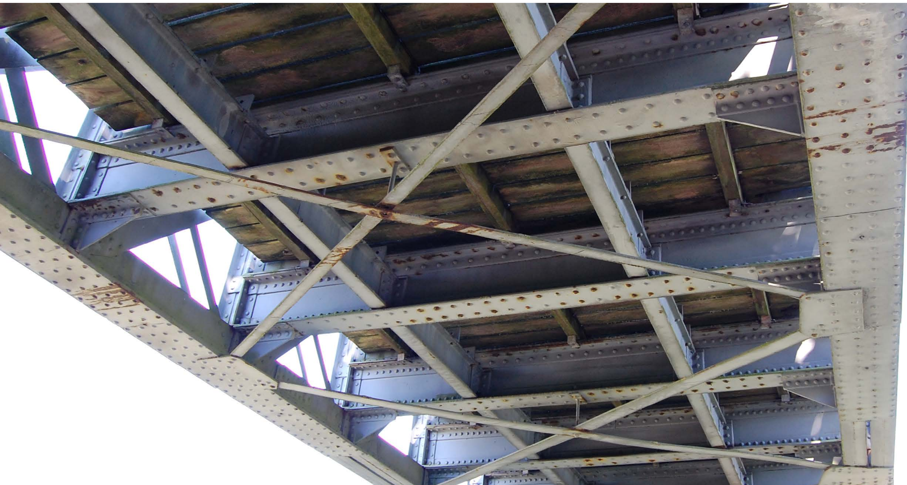
ONDERAANZICHT SPOORBRUG OVER OVERSTORTWEG
