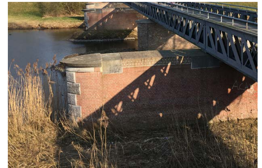
RAAKVLAK: METSELWERK PIJLERS EN STALEN SPOORBRUG
