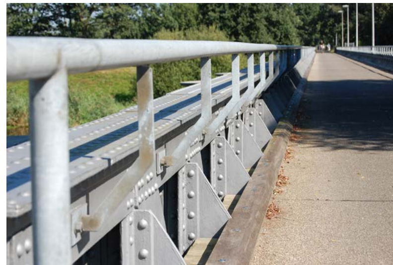
HANDREGEL AAN NOORDZIJDE SPOORBRUG
