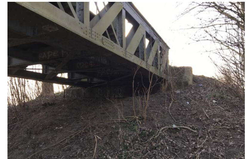
BESTAAND LANDHOOFD KW4
