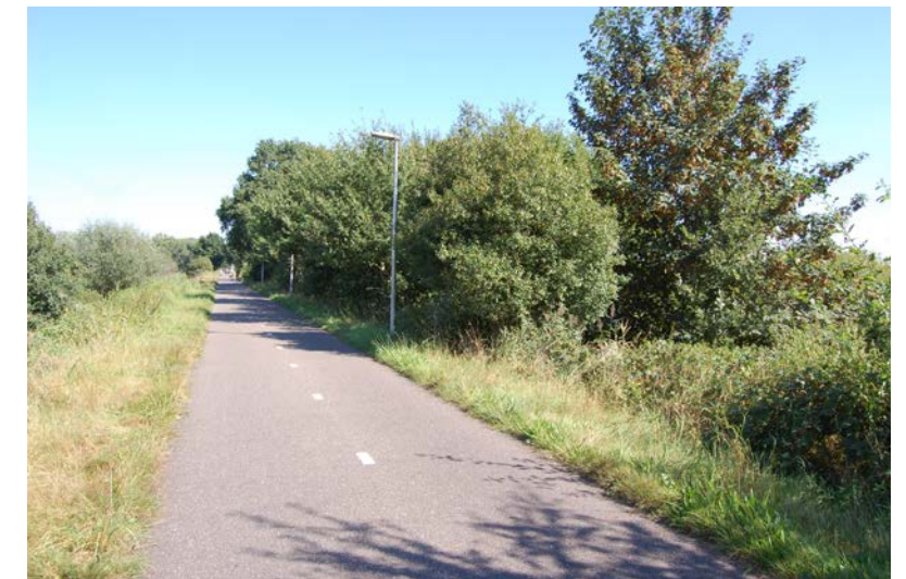
HUIDIG FIETSPAD OP SPOORDIJK
