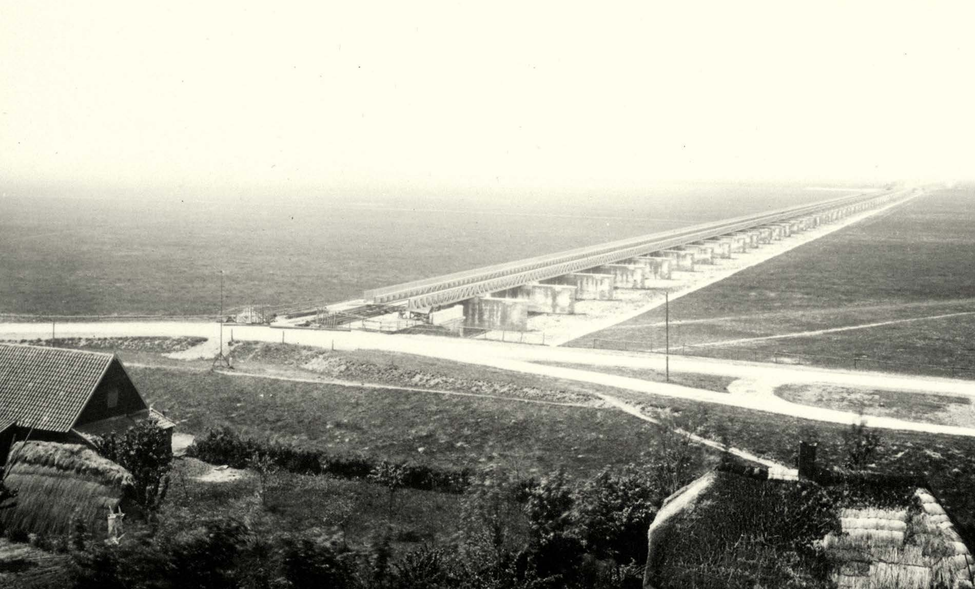
BRUG DOOR DE BAARDWIJKSE OVERLAAT 1885. GEZIEN VANAF DRUNEN
