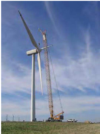
Figuur 4.3: Voorbeeld van een kraanopstelplaats nabij een turbine.
