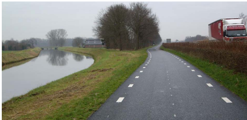
Afbeelding 7.15: Beeld vanaf kruising zuid Willemsvaart en Runweg naar het zuidoosten. Zicht op de gekanaliseerde loop van de Aa
