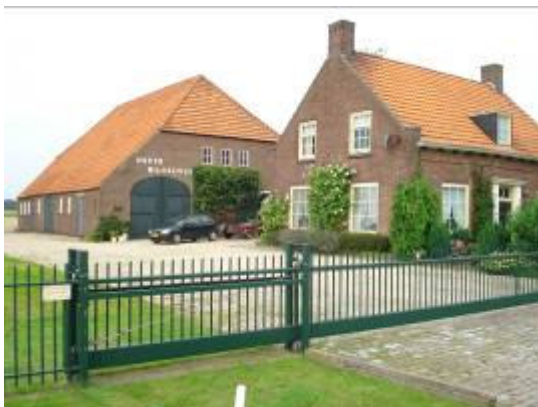
Vooraanzicht woning met achterliggende schuur
