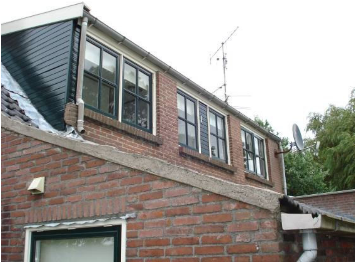
Dakopbouw achterzijde woning
