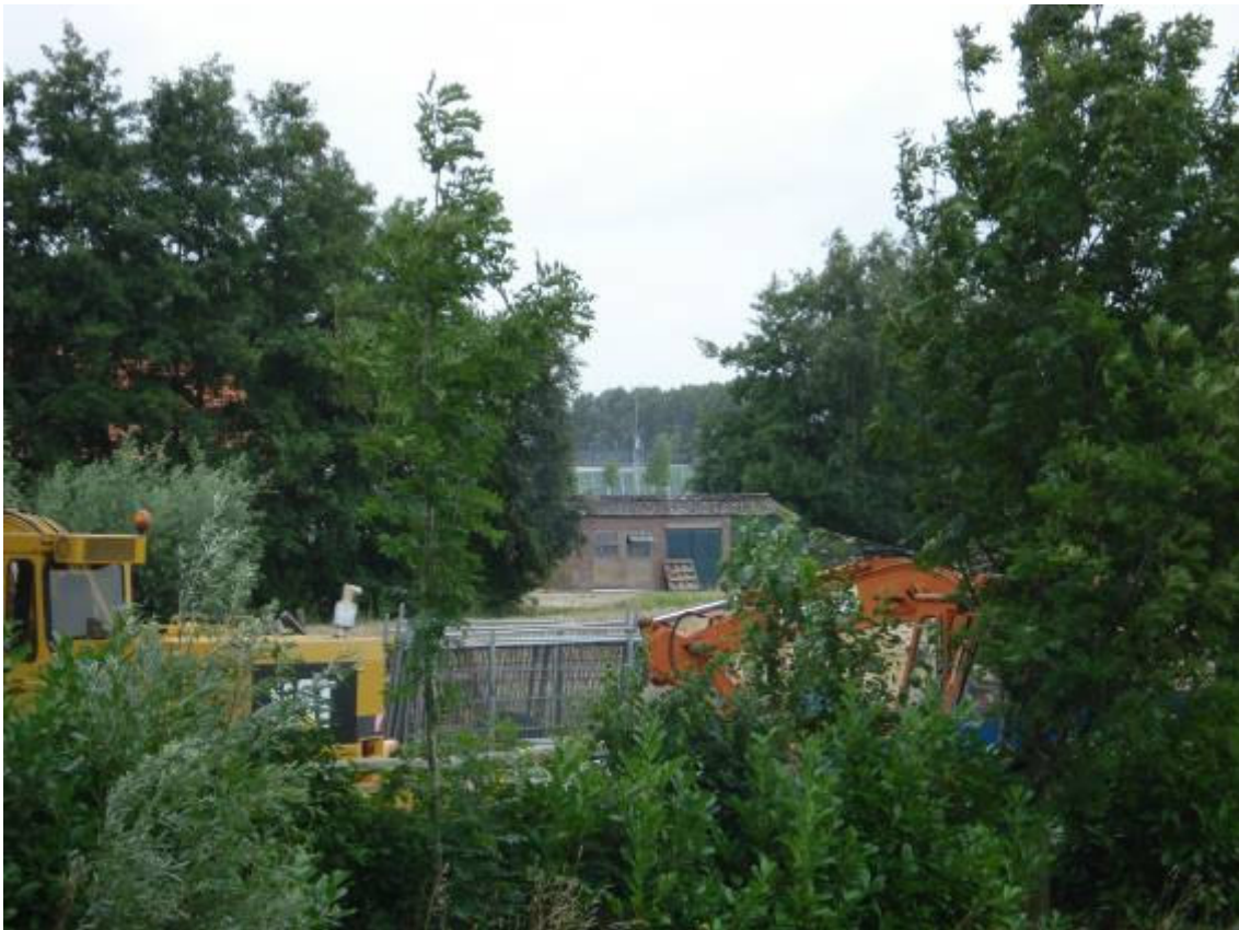
Kleine schuren behorend bij Moerdijkseweg 38 met vermoedelijk asbesthoudende beplating.
