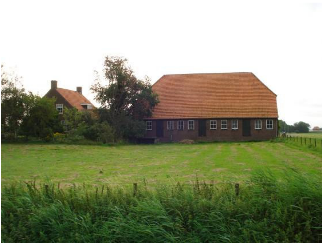
Zijaanzicht schuur met woning
