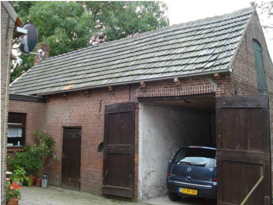
Aanbouw garage/schuur achterzijde woning
