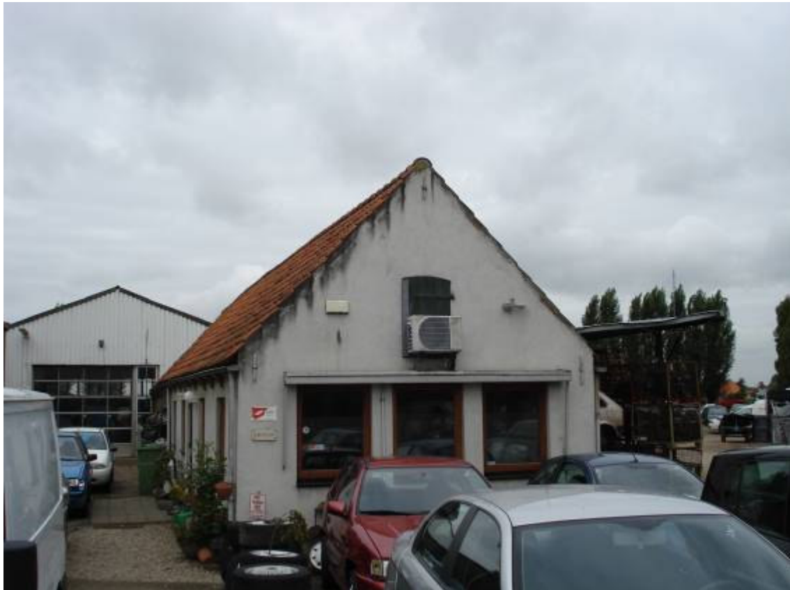
Kantoor op terrein
