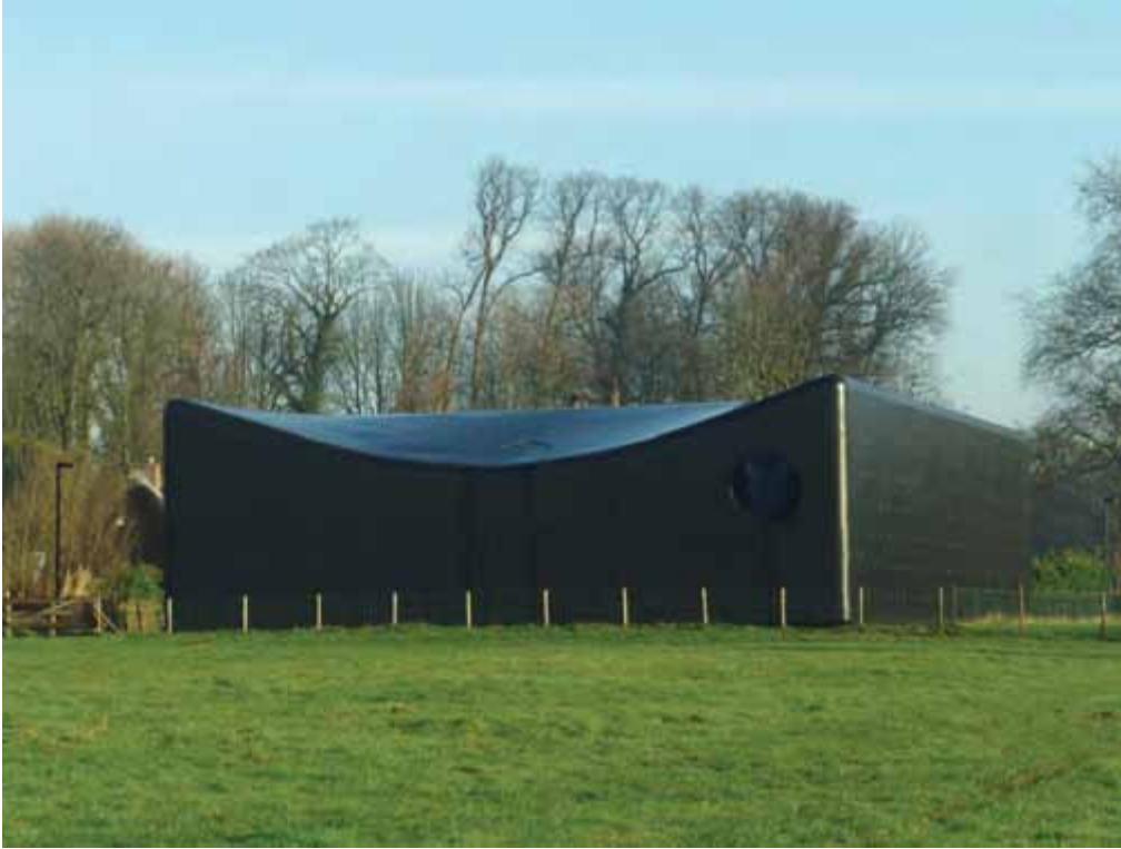
Warmte overdracht station, NL Architects, Leidsche Rijn, Utrecht (NL)
