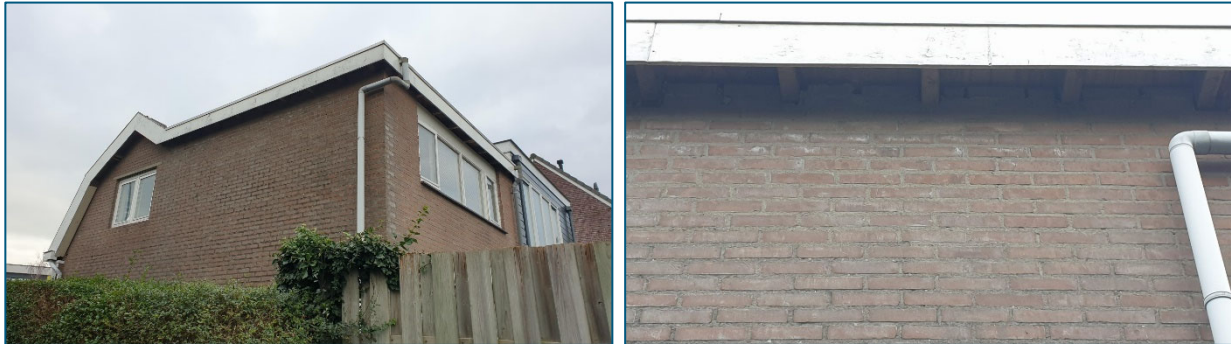
Figuur 4-2. De zuid- en oostzijde van Hillegommedijk 55, met de dakrand met overstek en stootvoegen die de vleermuizen toegang geven tot de spouw. Foto's: RHDHV, 2020.
