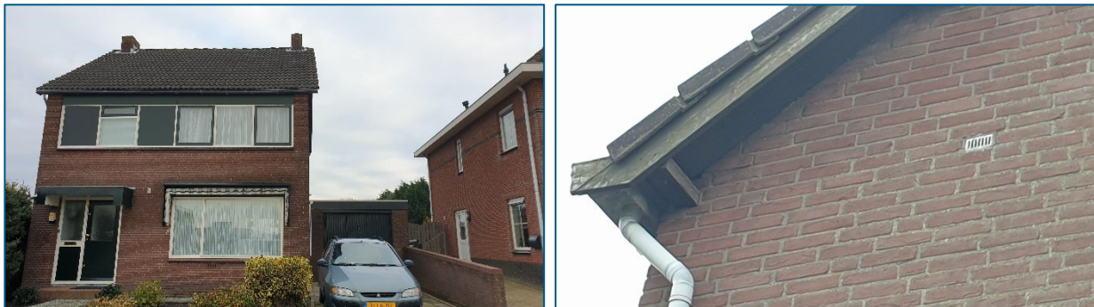
Figuur 4-3. De west- en zuidzijde van Hillegommedijk 52, met de opening net boven de gording stootvoegen die de vleermuizen toegang geven tot de spouw en het dak. Foto's: RHDHV, 2020.
