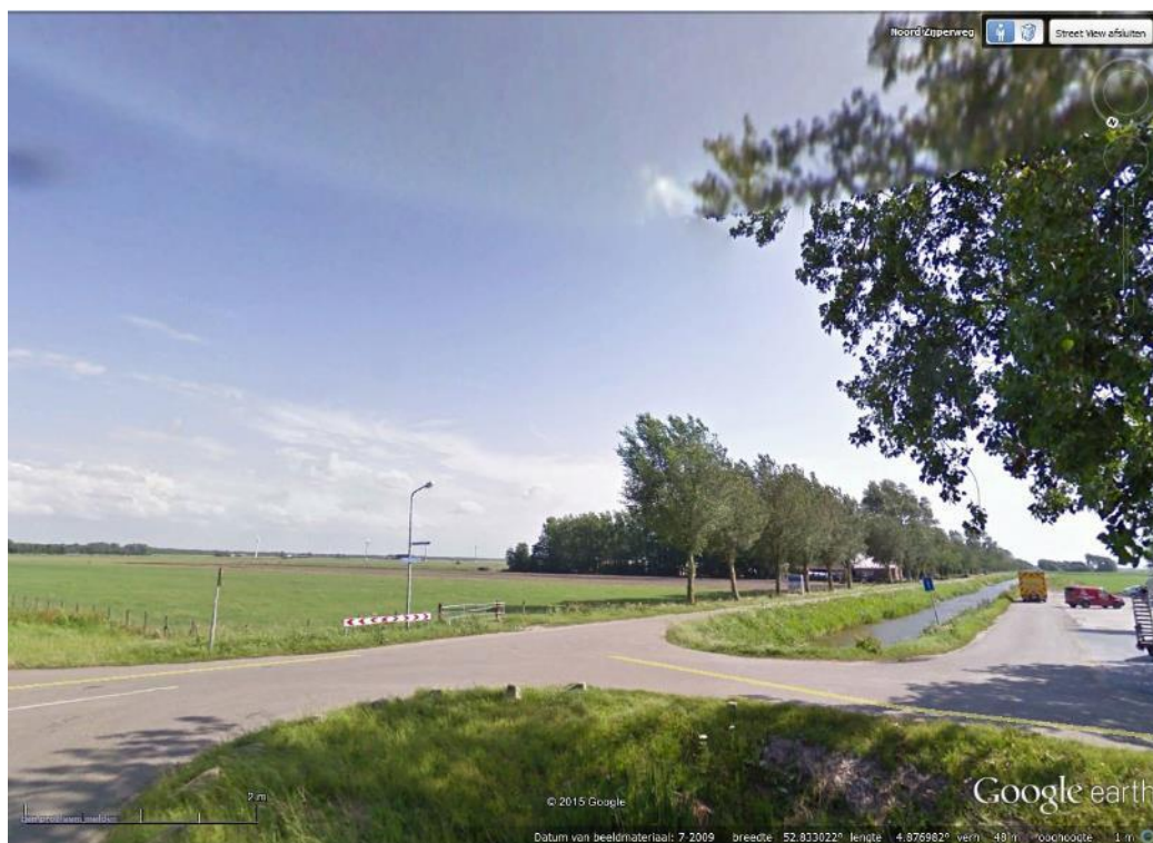
Figuur E Foto windpark WP Energiek. Standplaats: Noord Zijperweg
