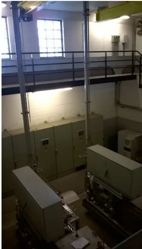
Figuur 3: Ramen in waterkerende kopwand een laag gelegen bedieningsruimte met schakelkast (rechts) bij de Spuisluis
