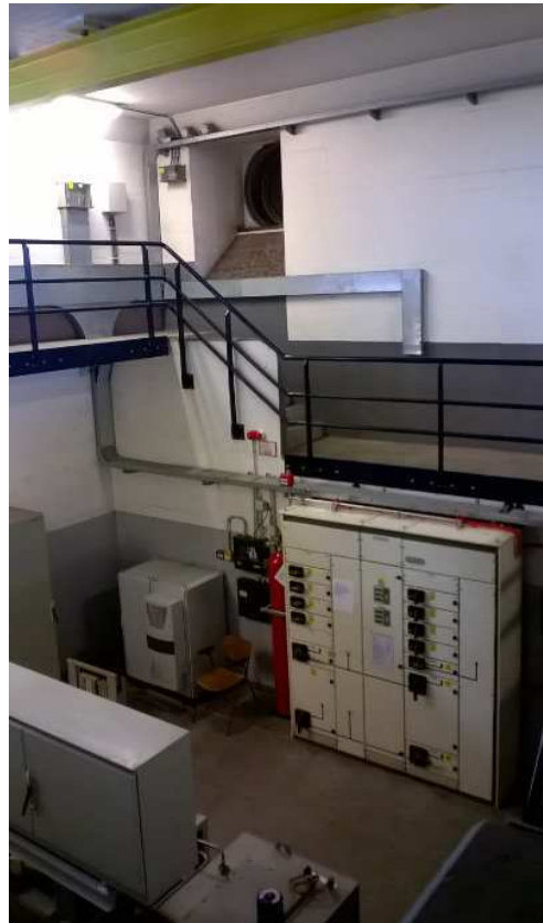
Figuur 3: Ramen in waterkerende kopwand een laag gelegen bedieningsruimte met schakelkast (rechts) bij de Spuisluis
