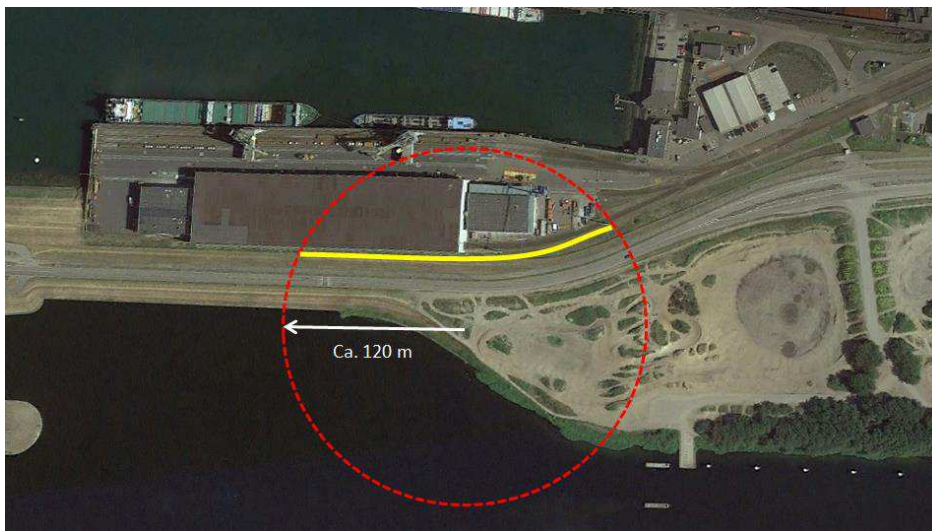
Figuur 6-5: dijkvak dat geraakt kan worden door de gondel bij omvallen van de mast
