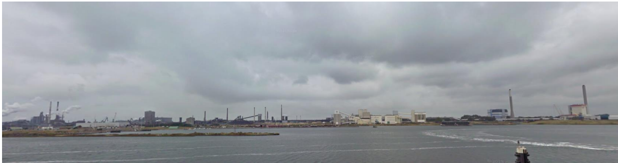
Figuur 3: uitzicht op Spuisluis vanaf Kanaaldijk, IJmuiden
