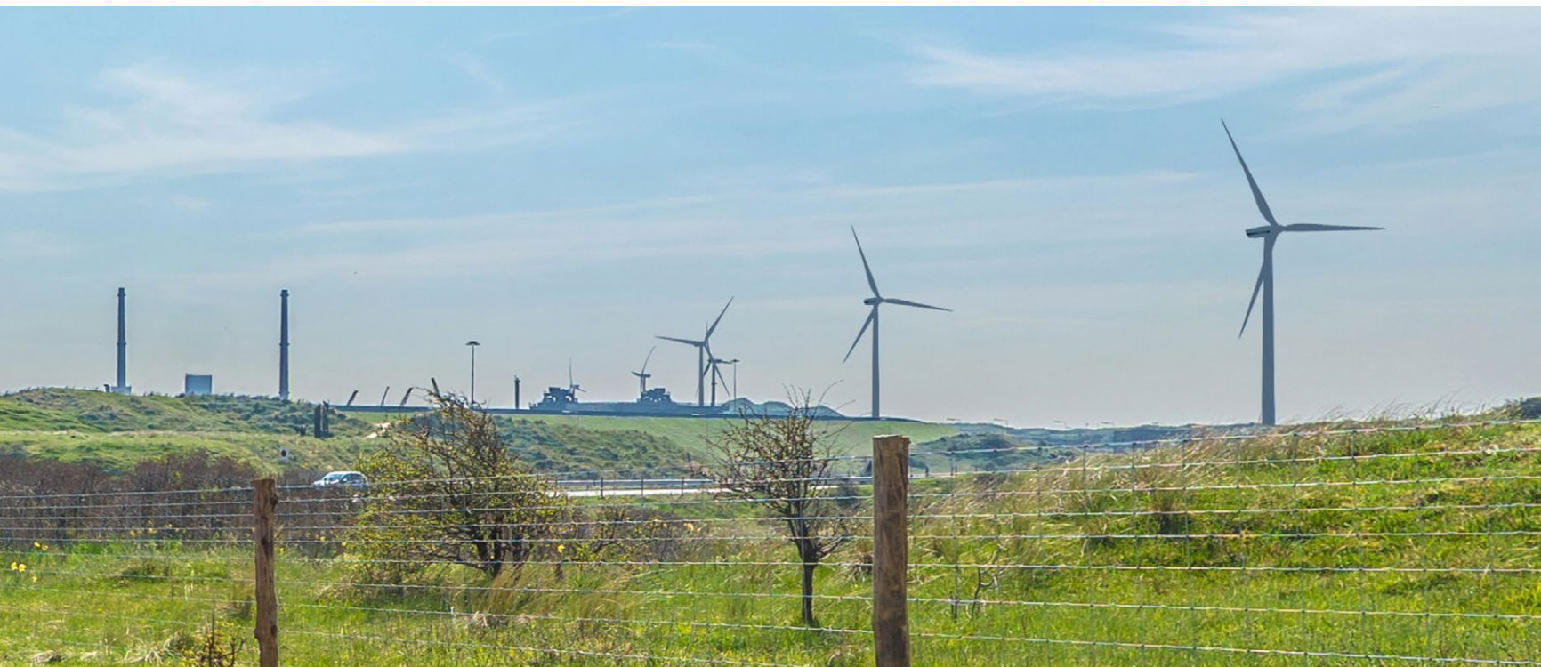
de lijnopstelling langs de westelijk rand van het Tata Steel-terrein samen met de bestaande turbines langs de Reyndersweg rijzen op uit het duinlandschap
