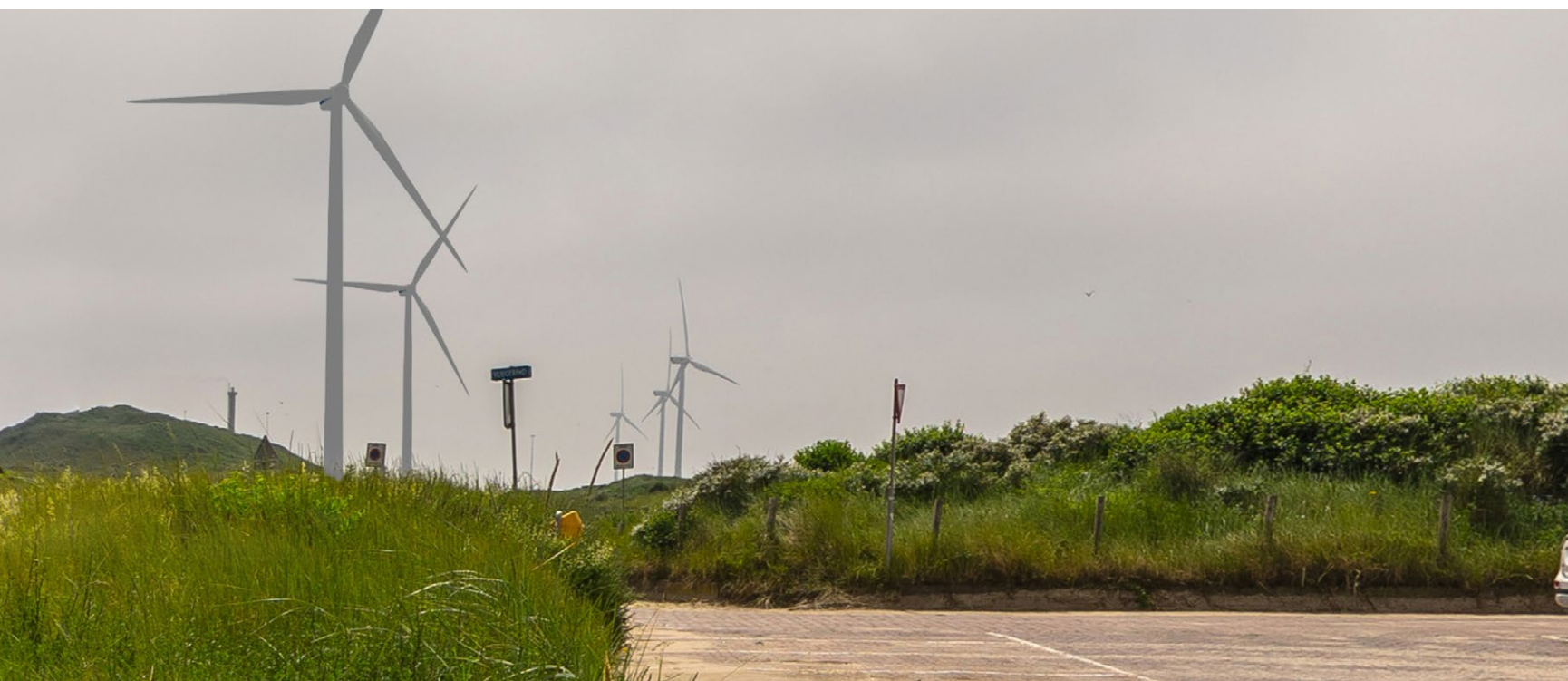
de nieuwe turbines op het Tata Steel terrein staan ten opzichte van de bestaande turbines aan de andere kant van de Reyndersweg, waardoor een lichte verspringing in de totale lijn ontstaat
