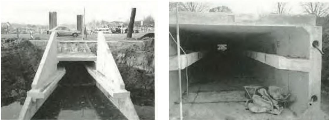
**Figuur 11: Voorbeeld van ecoducers (bron: J.G. Oord et al, 1995<sup>8</sup>)**
