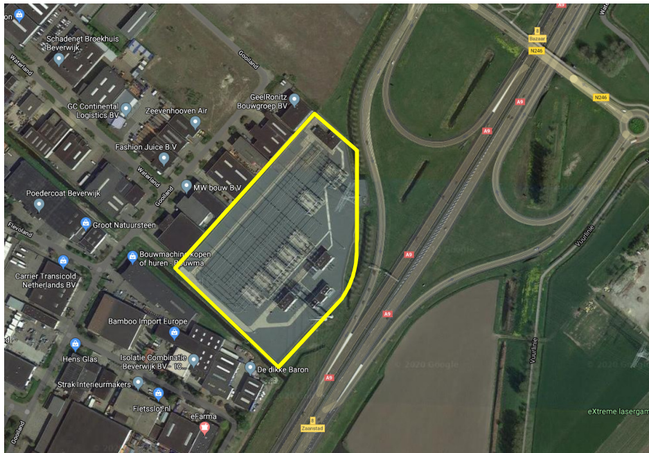
Figuur 2.4: huidige 380kV-station Beverwijk met locatie nieuwe transformator (bron: TenneT / Google Maps)
