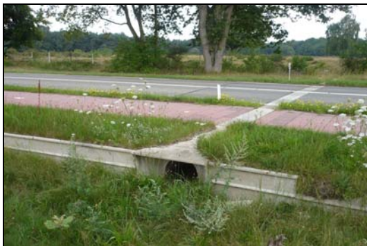
Foto 6. Faunatunnel onder Boissevainweg.
