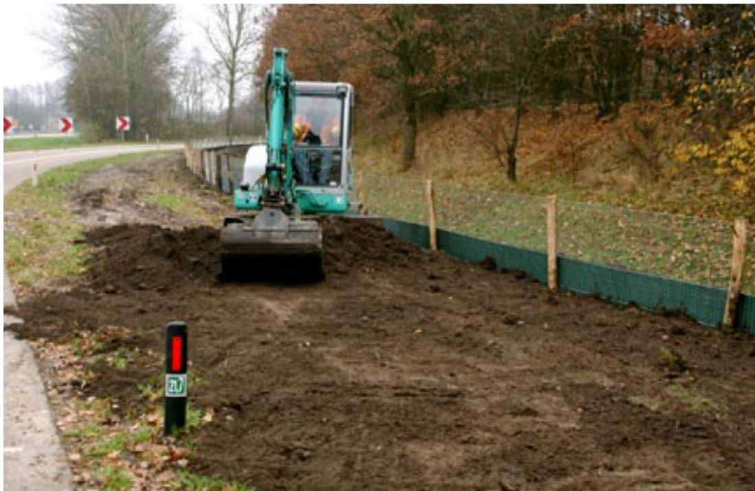
Figuur 7.3 Voorbeeld van een amfibieënraaster (Prudon & Creemers, 2004; Wansink et al., 2013)
