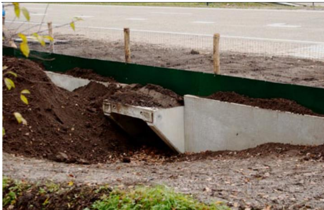
Figuur 5.3 Voorbeeld van (de aanleg van) een kleine faunatunnel, inclusief een kerend raster (Wansink et al., 2013)
